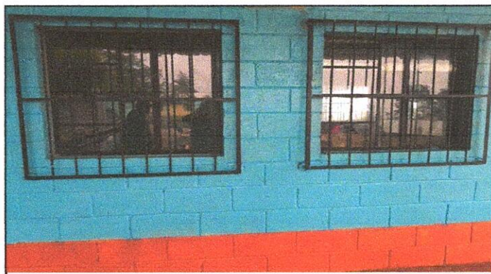
Foto 4: Sustitución de ventanas estructuras y vidrios
