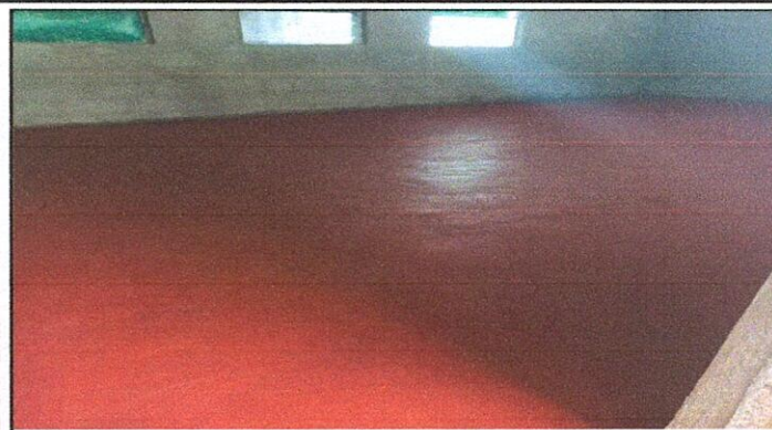
Foto1: Sustitución de piso de torta de concreto
