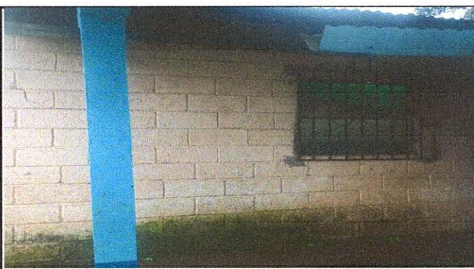
Foto 4: Mantenimiento a estructura de metal de ventana
