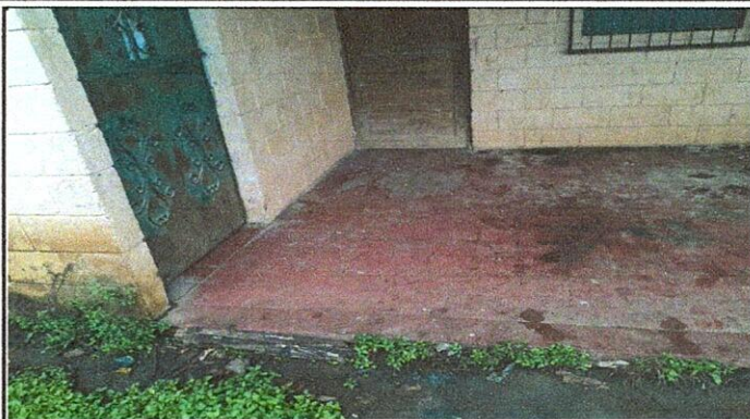
Foto1: Sustrucción de piso de torta de concreto
