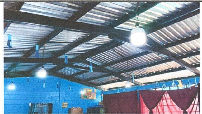
Foto 6: Reparación de sistema eléctrico
