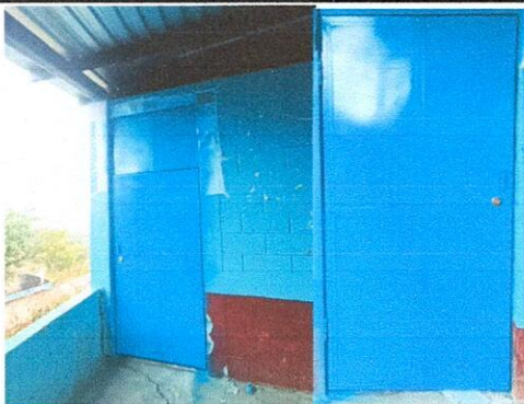
Foto 3: Mantenimiento a estructura
