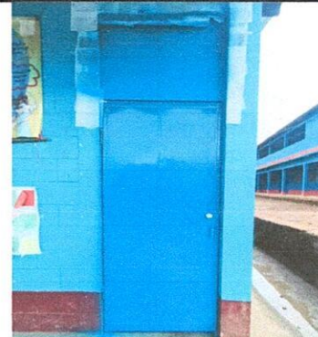
Foto 4: Mantenimiento a estructura
