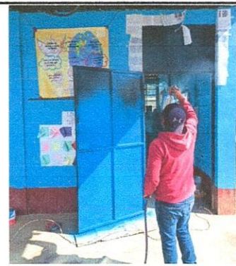
Foto 4: Mantenimiento a estructura
