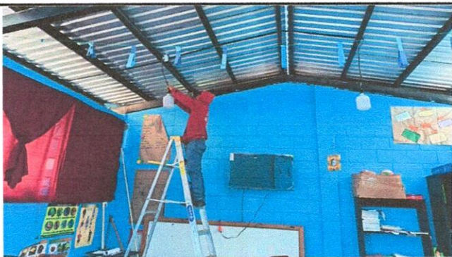
Foto 5: Reparación de sistema eléctrico
