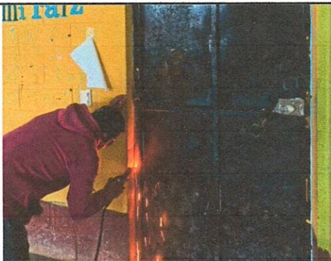
Foto 3: Mantenimiento a estructura
