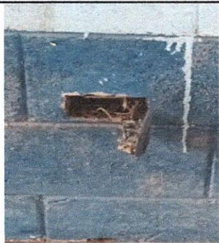
Foto 5: Reparación de sistema eléctrico
