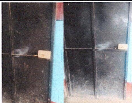
Foto 3: Mantenimiento a estructura
