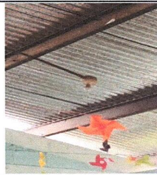
Foto 6: Reparación de sistema eléctrico
