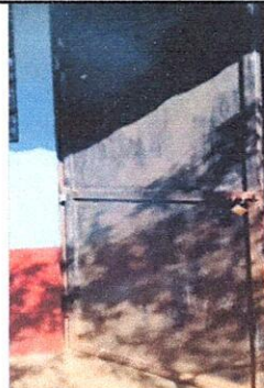
Foto 4: Mantenimiento a estructura
