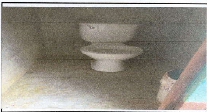
Foto 5: SUSTITUCIÓN SERVICIOS SANITARIOS Y SUS ACCESORIOS
