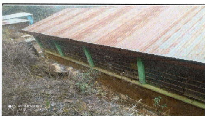
Foto 4: SUSTITUCIÓN PINTURA EN MUROS INTERIORES Y EXTERIORES
