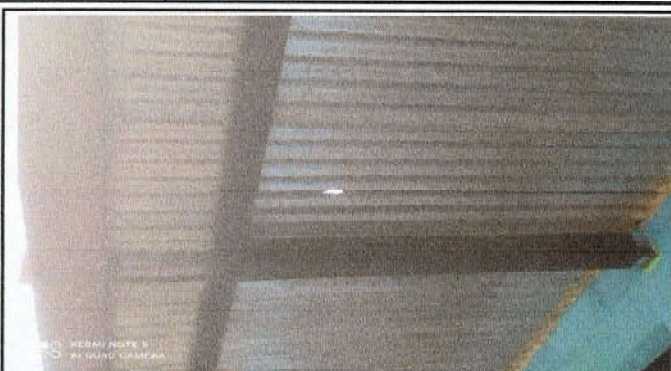
Foto 2: SUSTITUCIÓN ESTRUCTURA DE TECHO Y SOPORTE
