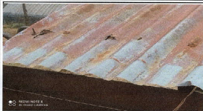
Foto 1: SUSTITUCIÓN CUBIERTA DE LÁMINA
