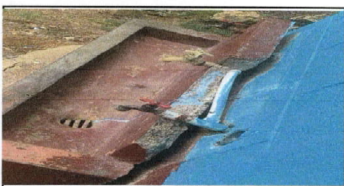
Foto 6: SUSTITUCIÓN RED DE AGUA POTABLE
