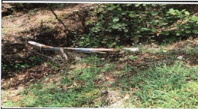
Foto 7: SUSTITUCIÓN RED DE DRENAJE
