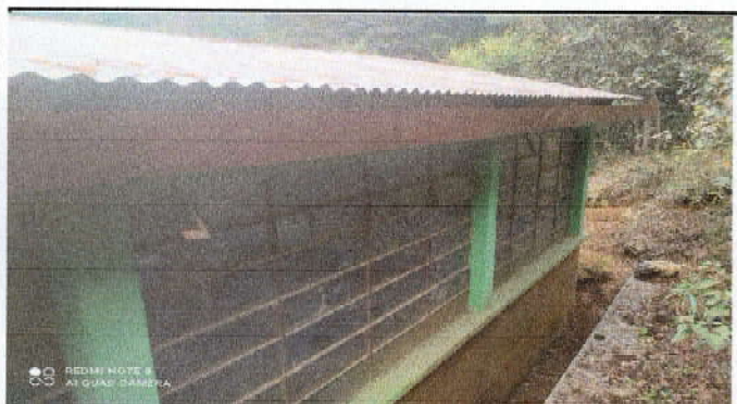
Foto 3: SUSTITUCIÓN CANALES Y BAJADAS DE AGUA PLUVIAL
