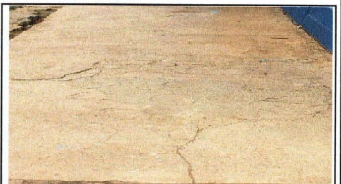
Foto 10: SUSTITUCIÓN LOSA DE PATIO
