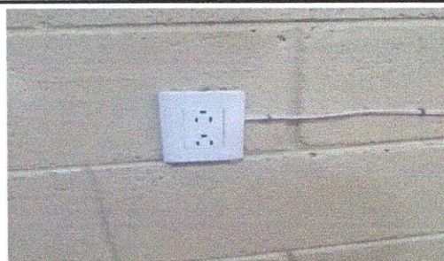
Foto 11: Sustitución de tomacorrientes dobles
