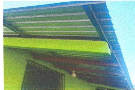
Foto 4: Sustitución de estructura de soporte de madera, por metal (costaneras)
