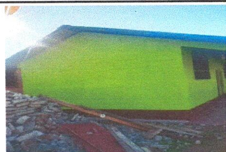
Foto 5: Pintura en muros exteriores e interiores
