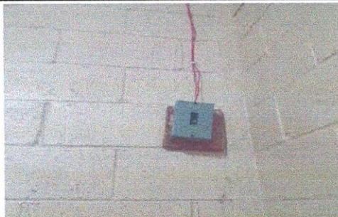
Foto 16: Sustrución de flipones
