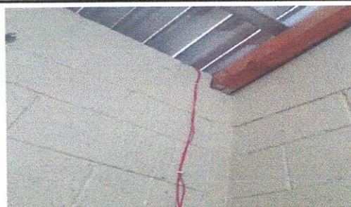
Foto 17: Reparación de cableado eléctrico
