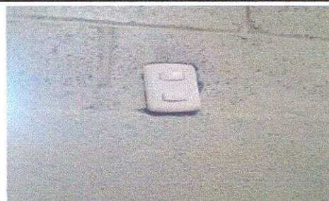
Foto 12: Sustitución de interruptores dobles
