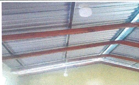
Foto13: Sustrución de plafoneras
