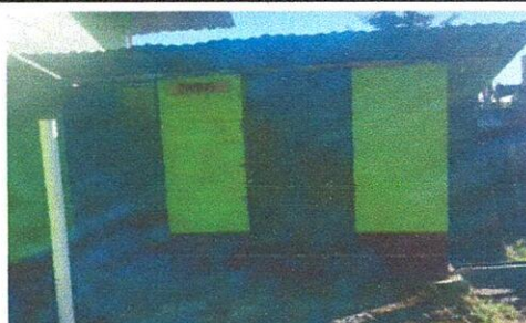
Foto 9: Sustitución de puerta en servicios sanitarios
