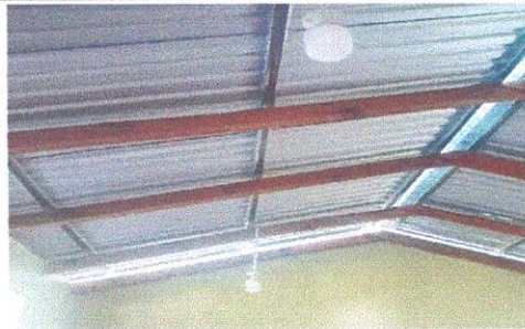
Foto 14: Sustrución de focos ahorradores
