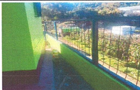
Foto 7: Reparación de tubo hg y electromalla
