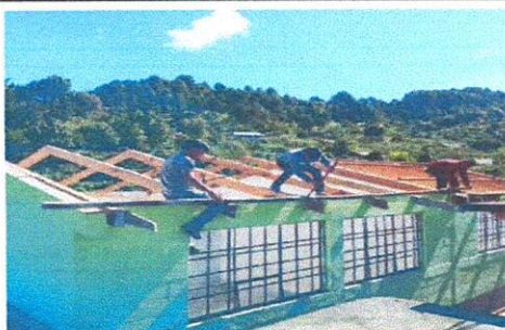
Foto 3: Sustitución de elementos de fijación (tornillos)
