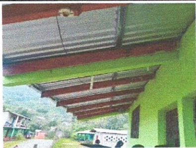
Foto 13: Sustitución de plafoneras
