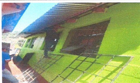
Foto 10: Sustitución de balcones de metal
