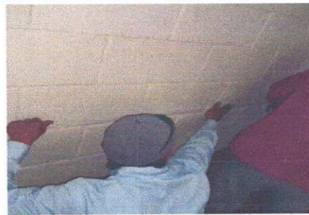
Foto 16: Sustitución de flip-flops
