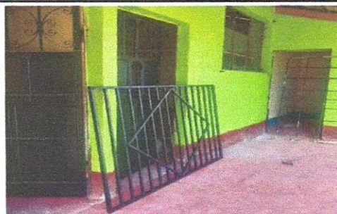
Foto 8: Mantenimiento a estructura (lijado, cambio de tubo, cepillado, sujeciones, aplicación de pintura)
