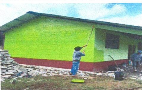
Foto 5: Pintura en muros exteriores e interiores
