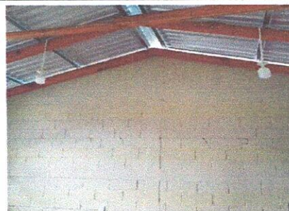
Foto 14: Sustitución de focos ahorradores
