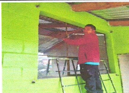
Foto 15: Sustitución de vidrios
