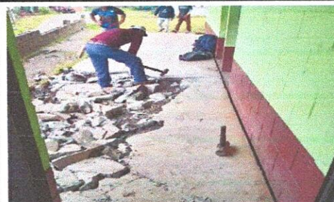
Foto 6: Sustitución de piso de torta de concreto
