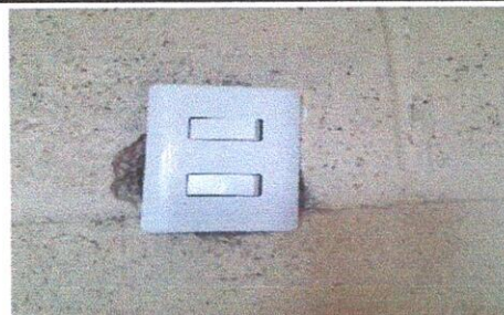
Foto 12: Sustitución de interruptores dobles
