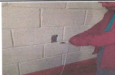
Foto 11: Sustitución de tomacorrientes dobles
