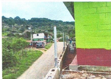
Foto 7: Reparación de tubo hg y electromalla
