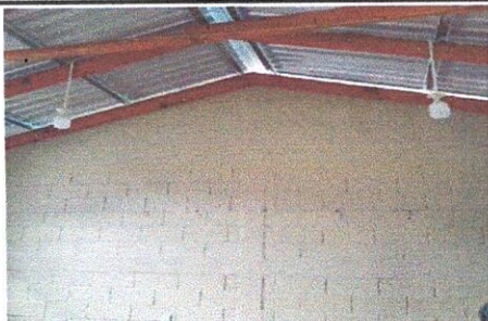
Foto 17: Reparación de cableado eléctrico
