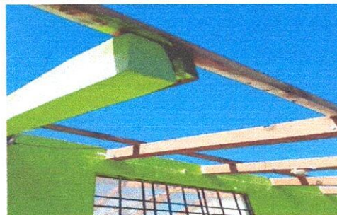
Foto 4: Sustitución de estructura de soporte de madera, por metal (costaneras)
