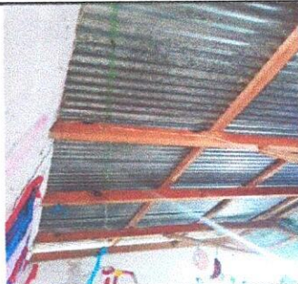
Foto 17: Reparación de cableado eléctrico
