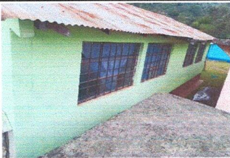
Foto 3: Sustrución de elementos de fijación (tornillos)
