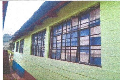
Foto 10: Sustitución de balcones de metal
