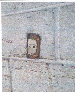
Foto 11: Sustitución de tomacorrientes dobles
