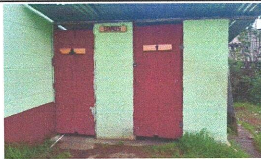
Foto 9: Sustitución de puerta en servicios sanitarios
