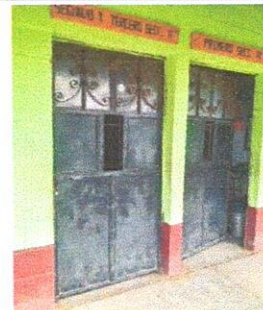
Foto 8: Mantenimiento a estructura (lijado, cambio de tubo, cepillado, sujeciones, aplicación de pintura)
