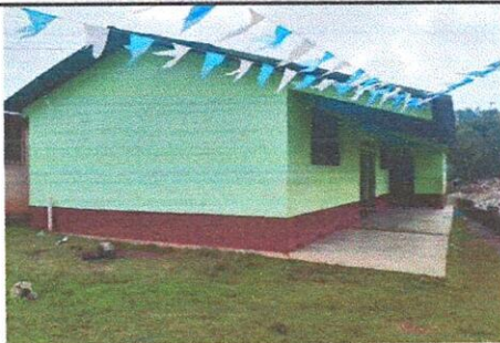
Foto 5: Pintura en muros exteriores e interiores
