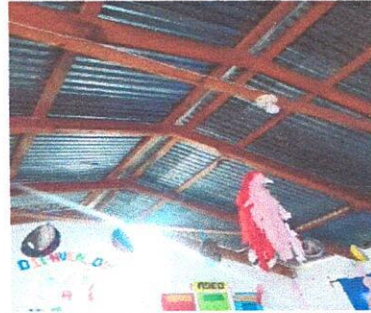
Foto 14: Sustrucción de focos ahorradores
