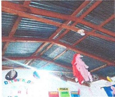
Foto 13: Sustrucción de plafoneras
