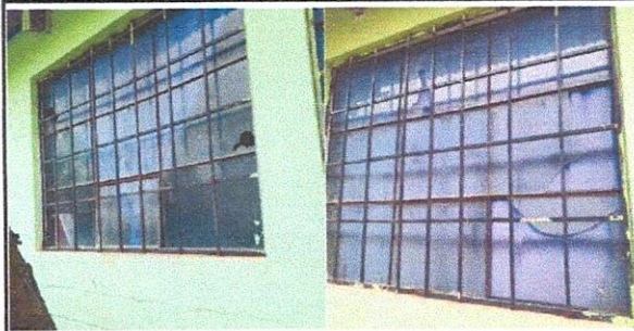
Foto 15: Sustrucción de vidrios
