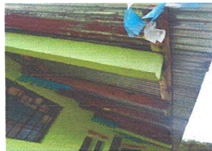
Foto 4: Sustrución de estructura de soporte de madera, por metal (costaneras)
