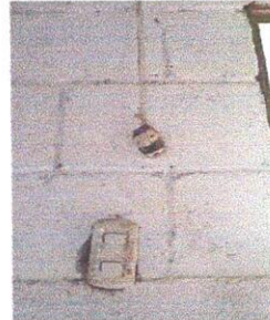
Foto 12: Sustitución de interruptores dobles
