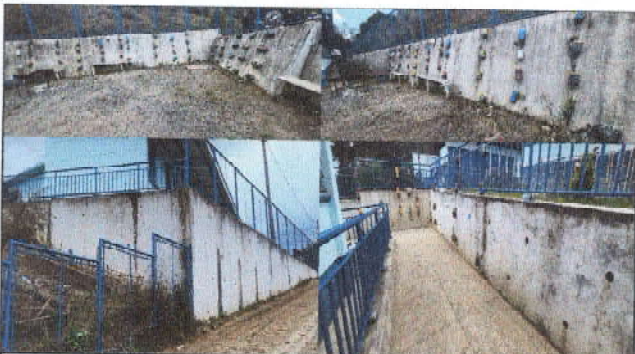
Foto 4: Pintura en muros exteriores e interiores
