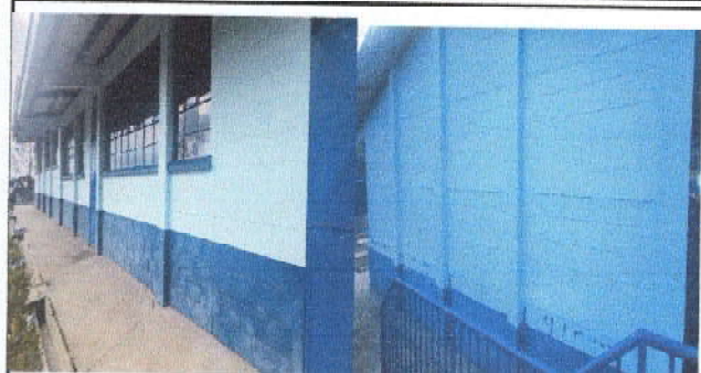
Foto 2: Pintura en Paredes Exteriores
