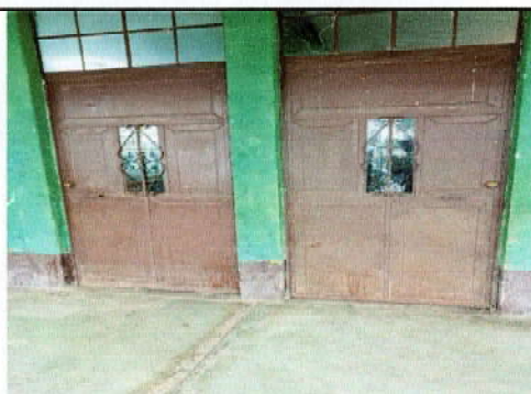
Foto 3: Puertas de Metal: Mantenimiento a estructura (lijado, cambio de tubo, cepillado, sujeciones, aplicación de pintura)
