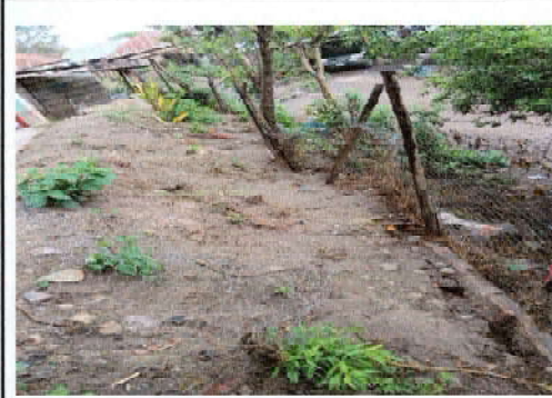
Foto 8: MUROS PERIMETRALES: Reparación de muro perimetral de block con tubo hg y malla galvanizada, soleras intermedias y columna
