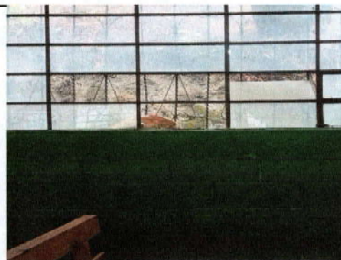
Foto 4: Ventanas: Sustitución de vidrios
