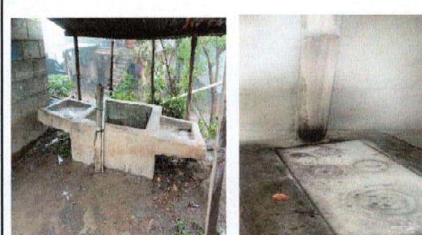
Foto 10: REPARACION DE COCINA: Sustitución de pila de cemento de dos lavaderos
