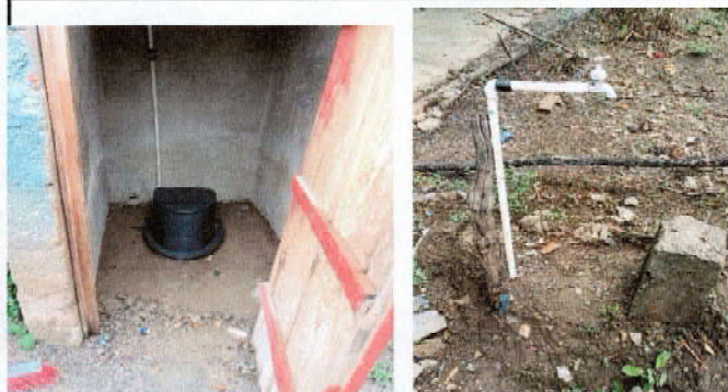
Foto 7: SERVICIOS SANITARIOS Y SUS ACCESORIOS: Sustitución de inodoro, sustitución de lavamanos
