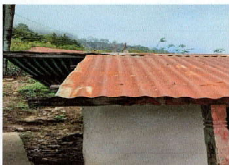
Foto 1: Cubierta de lamina: sustitución de lámina por lámina troquelada
