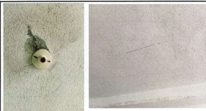
FOTO 2: Impermeabilización de losa
