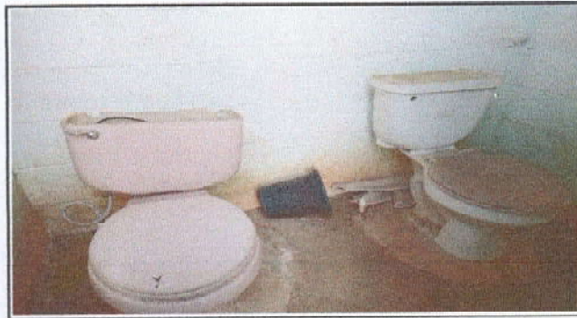
Foto 4: sustitución de inodoros
