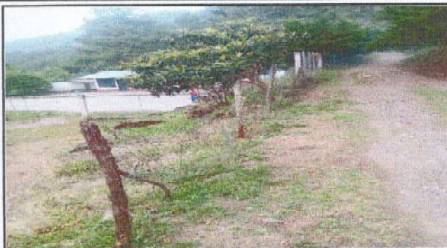
Foto 2: Sustitución de muro perimetral
