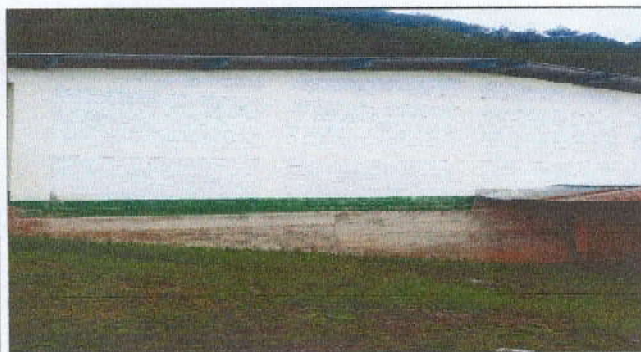
Foto 3: Pintura de muro en exterior y interior de la escuela
