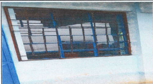
Foto 1: Sustitución de balcones
