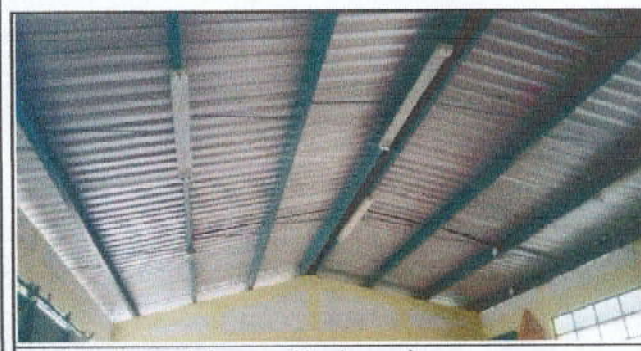
Foto 5: Sustitución de focos y cables de energía
