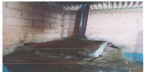
Foto 6: REPARACION DE COCINA
