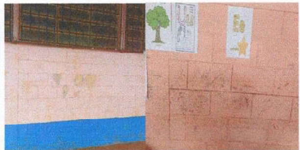
Foto 4: PINTURA EN MUROS EXTERIORES E INTERIORES
