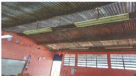
Foto 3: REPACION DE SISTEMA ELECTRICO
