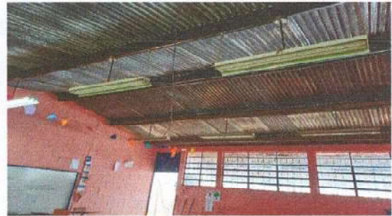
Foto 2: ESTRUCTUTRA DE TECHO
