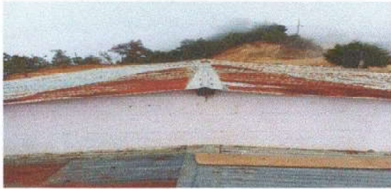
Foto1: CUBIERTA DE LAMINA
