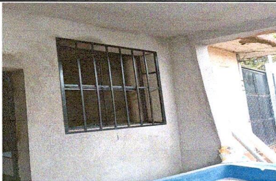
Foto1: 5.3 SUSTITUCIÓN DE VENTANAS DE MADERA POR METAL MAS VIDRIO Y BALCON
