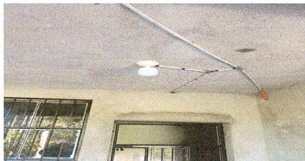
Foto 1: 16.11 REPARACIÓN DE CABLEADO ELECTRICO
