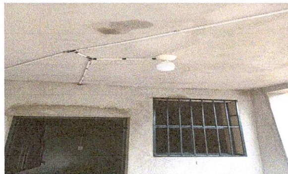
Foto 2: 16.12 SUSTITUCIÓN DE DUCTO ELÉCTRICO + ACCESORIOS
