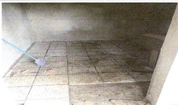
Foto 5: 20 REPELLO EN PAREDES DE LA COCINA CERNIDO
