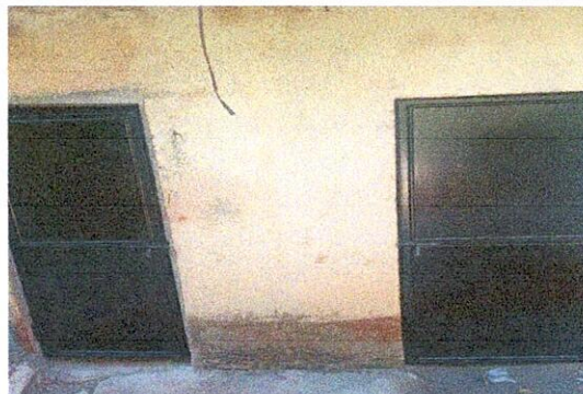
Foto 2: 4.4 SUSTITUCIÓN DE PUERTAS EN SERVICIO SANITARIO
