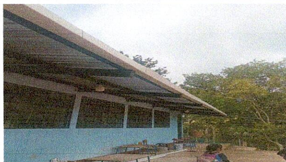
Foto 5: 7.2 SUSTITUCIÓN DE CANAL DE PVC
