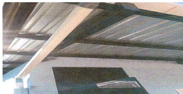
Foto 4: 7.3 SUSTITUCIÓN DE BAJADA DE AGUA PLUVIAL, TUBO PVC 3PULGADAS
