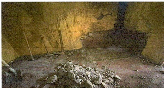
Foto 5: 20 REPELLO EN PAREDES DE LA COCINA CERNIDO
