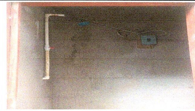
Foto 6: 10.7 SUSTITUCIÓN DE MEZCLADORA PARA DUCHA
