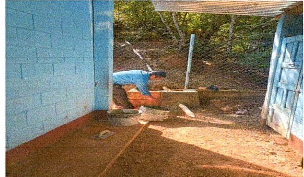
Foto 2:SUSTITUCIÓN DE TUBERÍA LINEA PRINCIPAL DE AGUAS NEGRAS
