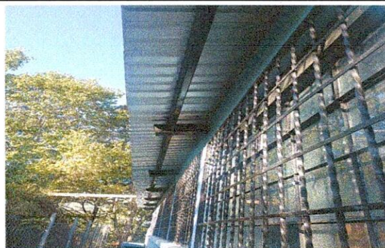
Foto 5: 7.2 SUSTITUCIÓN DE CANAL DE PVC
