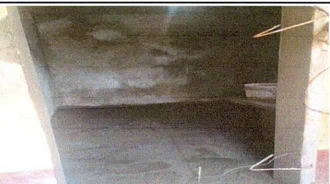
Foto 3: SUSTITUCIÓN DE PISO DE CEMENTO A PISO DE GRANITO
