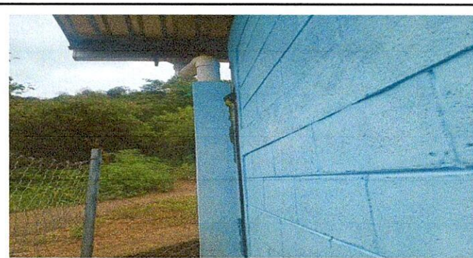
Foto 4: 7.3 SUSTITUCIÓN DE BAJADA DE AGUA PLUVIAL, TUBO PVC 3PULGADAS
