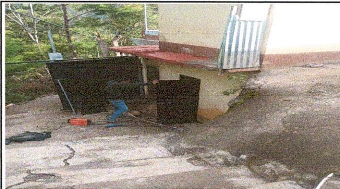
Foto 2: 4.4 SUSTITUCIÓN DE PUERTAS EN SERVICIO SANITARIO
