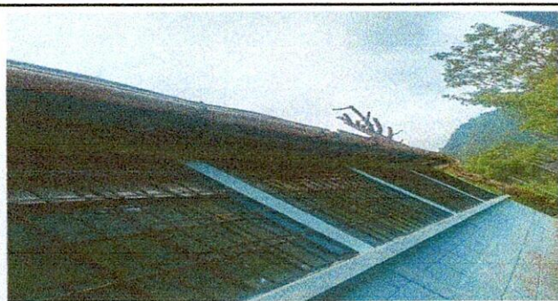
Foto 5: SUSTITUCIÓN DE CANAL DE PVC
