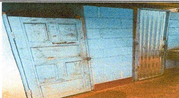
Foto1: SUSTITUCIÓN DE PUERTAS EN SERVIVIO SANITARIOS
