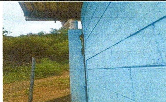
Foto 4: SUSTITUCIÓN DE BAJADA DE AGUA PLUVIAL, TUBO PVC 3PULGADAS
