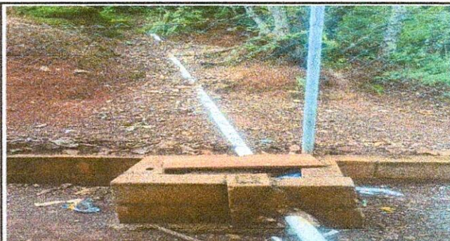
Foto 2:SUSTITUCIÓN DE TUBERÍA LINEA PRINCIPAL DE AGUAS NEGRAS
