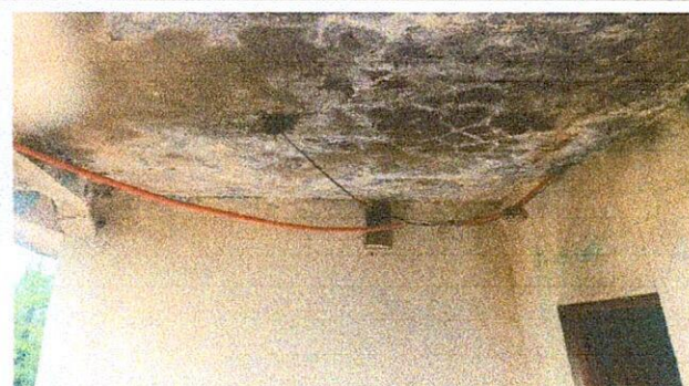
Foto 1: REPARACIÓN DE CABLEADO ELECTRICO
