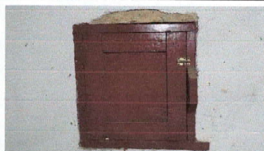
Foto 6: SUSTITUCIÓN DE VENTANAS
