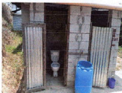
Foto 1: SUSTITUCIÓN DE PUERTAS A PUERTAS DE METAL PARA SERVICIOS SANITARIOS
