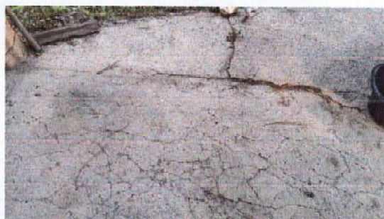
Foto 5: SUSTITUCIÓN DE TORTA DE CEMENTO EN EL PATIO
