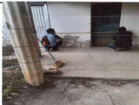
Foto 4: SUSTITUCIÓN DE PINTURA
