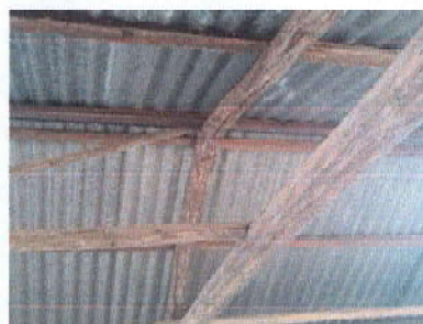
Foto 4: SUSTITUCIÓN DE LÁMINA
