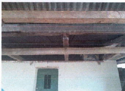
Foto 4: SUSTITUCIÓN DE ESTRUCTURA
