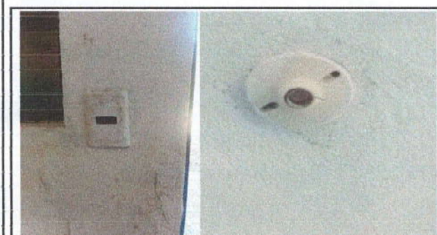
Foto 9: reparación de sistema eléctrico
