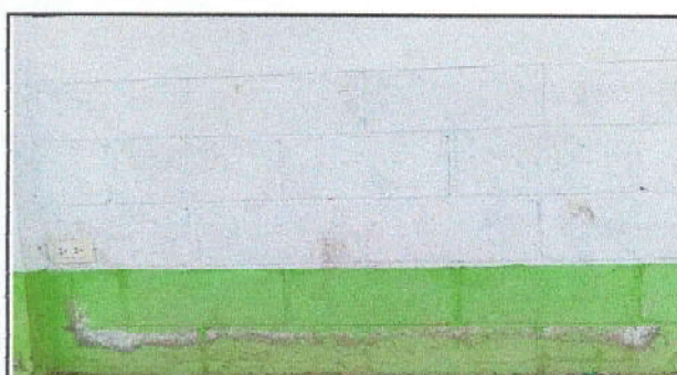
Foto 4: aplicación en muros exteriores e interiores
