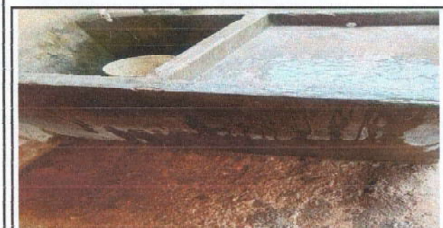
Foto 11: sustitución de pila
