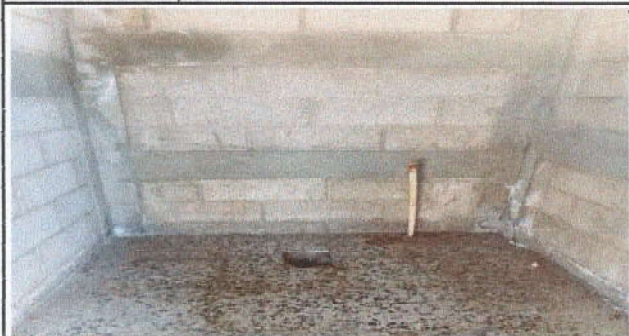
Foto 7: Mejoramiento de mingitorio
