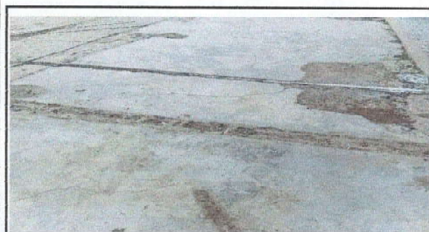
Foto 3: reparacion de piso de granito
