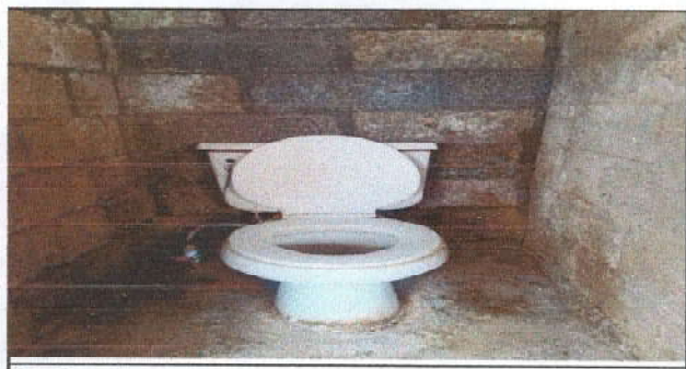
Foto 5: sustitucion de inodoros
