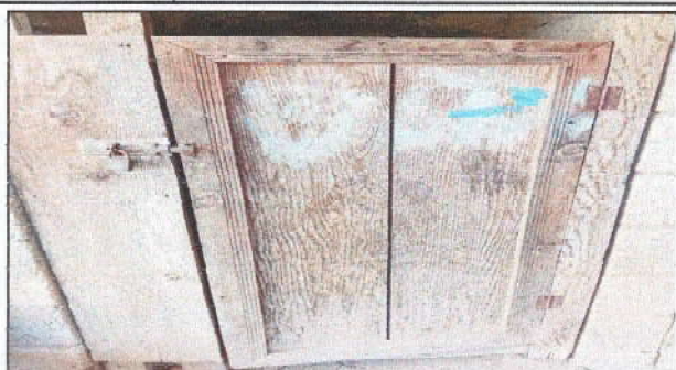
Foto 2: sustitución de puerta de servicio sanitario
