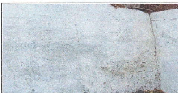
Foto 12: repello en muro
