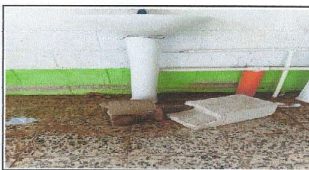
Foto 6: sustitucion de lavamanos
