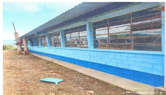
Foto 2: Culminación de pintura en paredes
