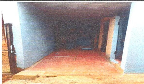
Foto 5: Acabado de pintura en paredes de baños
