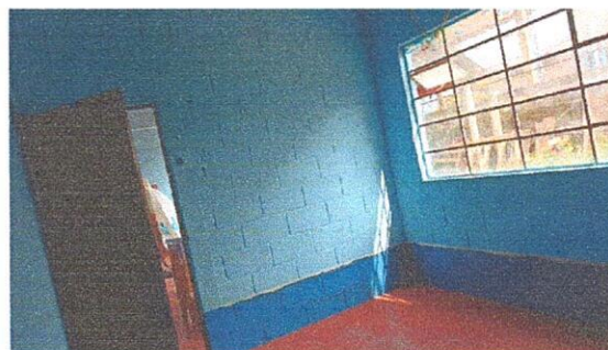
Foto 6: Acabado de pintura en paredes de dirección
