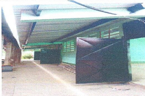
Foto 3: Culminación de pintura en puertas y colocación de techado
