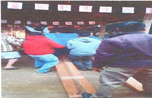
Foto 4: Recepción de pilas lavamanos
