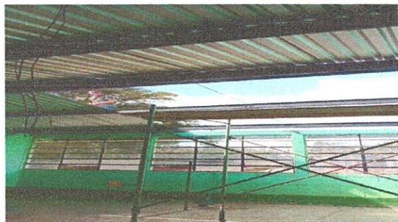
Foto 3: Colocación de lámina troquelada
