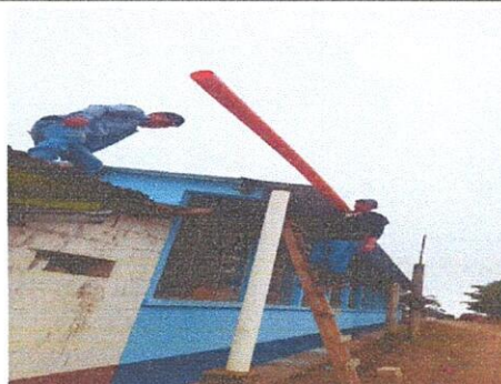
Foto 2: Colocación de canales para bajada de agua
