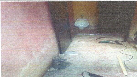
Foto 5: Instalación de mingitorios e inodoros
