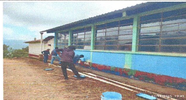
Foto 6: Preparación de áreas y pintado de paredes exteriores e interiores
