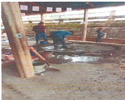
Foto 1: Preparación de la mezcla para la fundición del piso de torta
