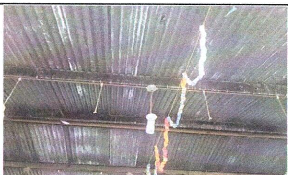
Foto 5: Sustitución de láminas por láminans troqueladas.
