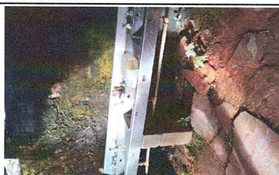
Foto 4: Sustitución de lavamanos por pilas.
