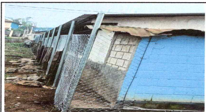
Foto 9: Mejoramiento de muro perimetral con tubo hg y malla galvanizada
