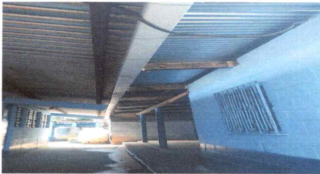
Foto 5: Sustitución de soporte o pescante para canal
