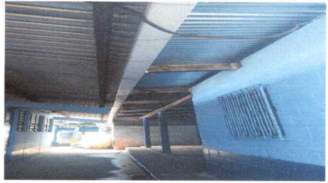
Foto 4: Sustitución de canal de PVC
