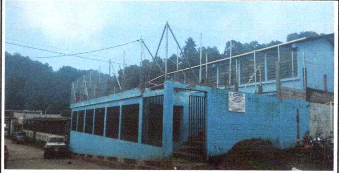
Foto 6: Mejoramiento de baranda de tubo hg y malla galvanizada
