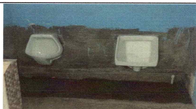
Foto 10: Mejoramiento de mingitorios
