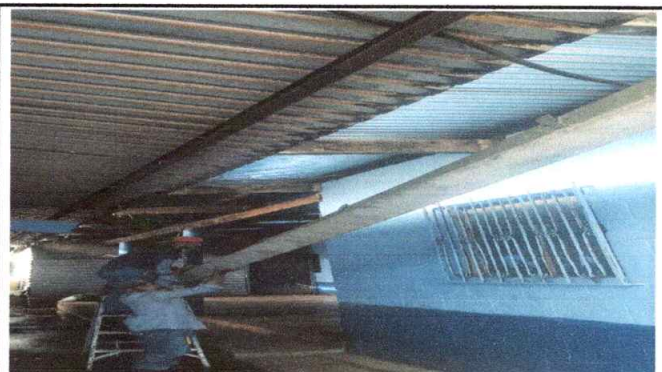
Foto 4: Sustitución de canal de PVC
