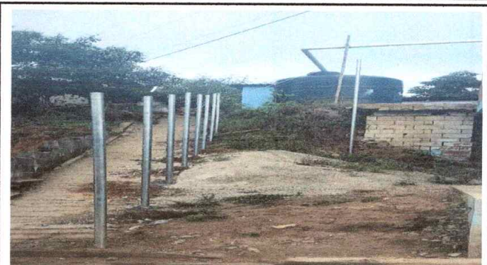
Foto 8: Mejoramiento de muro perimetral con tubo hg y malla galvanizada
