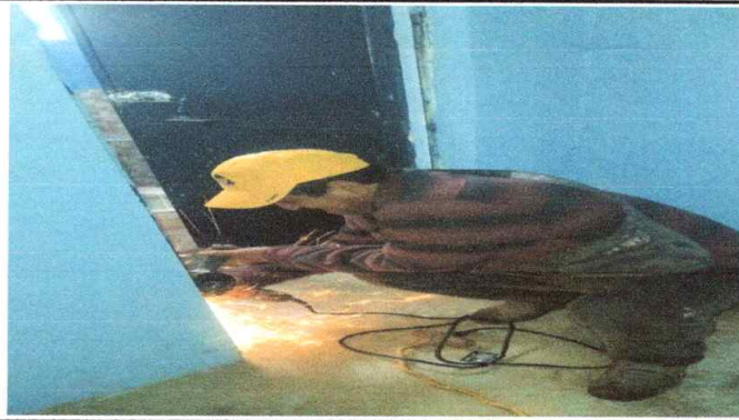
Foto 1: Mantenimiento a puerta
