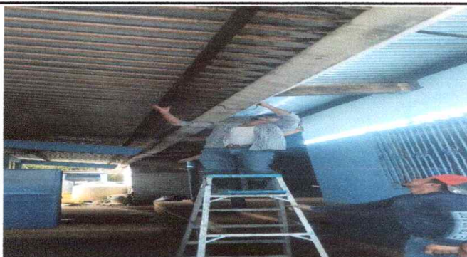
Foto 5: Sustitución de soporte o pescante para canal
