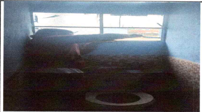
Foto 2: Sustitución de vidrios
