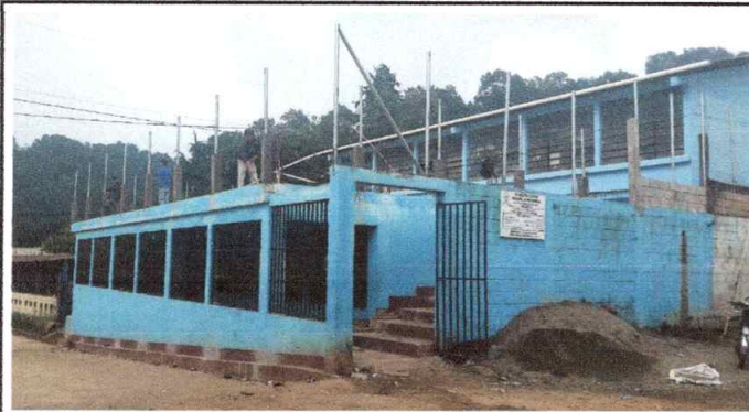
Foto 7: Mejoramiento de baranda con tubo hg y malla galvanizada
