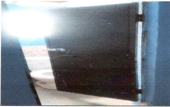
Foto 1: Mantenimiento a puerta
