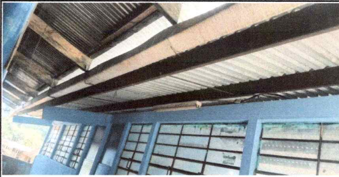
Foto 5: Sustitución de soporte o pescante para canal
