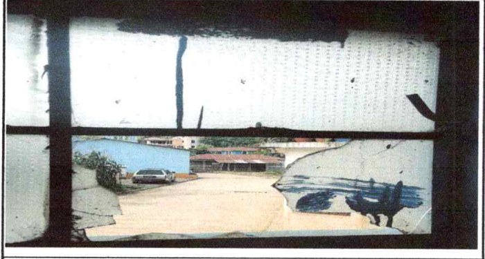
Foto 2: Sustitución de vidrios
