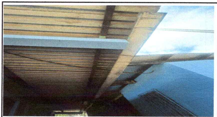
Foto 4: Sustitución de canal de PVC
