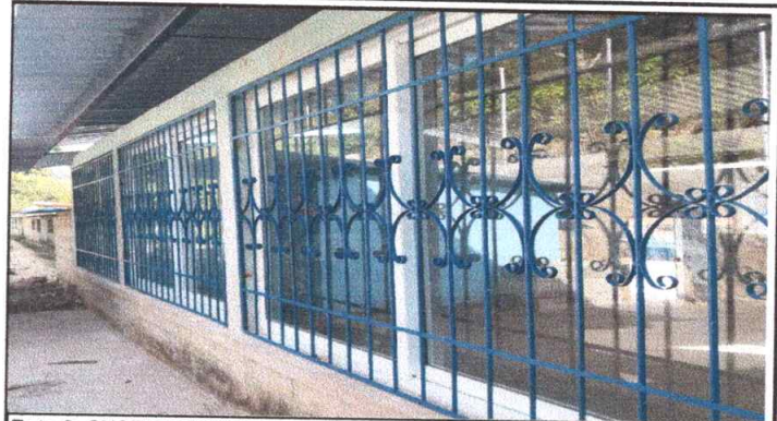
Foto 2: SUSTITUCION DE BALCONES DE METAL
