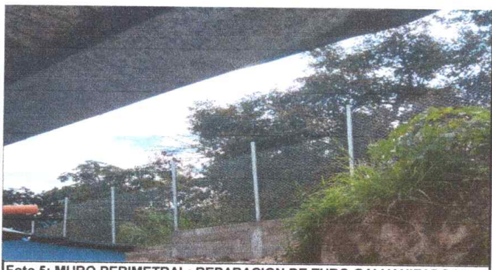
Foto 5: MURO PERIMETRAL: REPARACION DE TUBO GALVANIZADO Y MALLA GALVANIZADA
