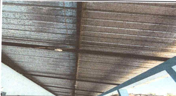
Foto 1: REPARACION DE SISTEMA ELECTRICO: REPARACION DE CABLEADO ELECTRICO
