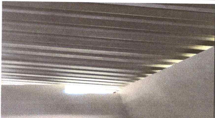
SUSTITUCIÓN DE ESTRUCTURA DE SOPORTE DE METAL
