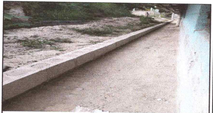
REPARACION DE CUNETAS
