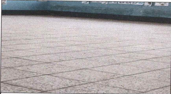
SUSTITUCION DE PISO DE CONCRETO POR GRANITO
