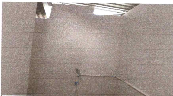
Foto 4: REPARACION DE REPELLO Y CERNIDO DE PAREDES (CUANDO APLIQUE): CERNIDO EN MURO
