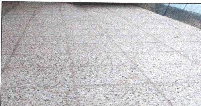
SUSTITUCION DE TUBERIA PVC LINEA PRINCIPAL AGUAS NEGRAS
