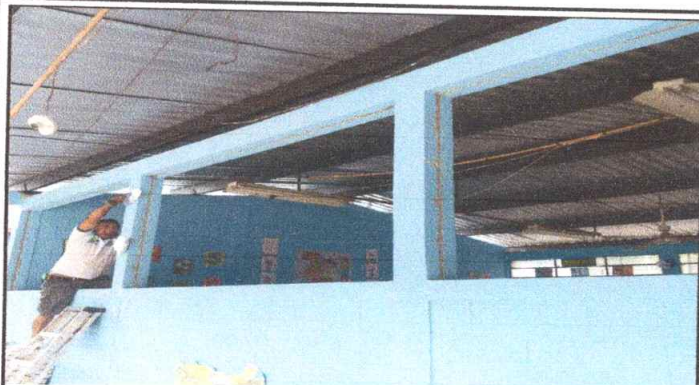
SUSTITUCION DE VENTANAS DE METAL POR UPVC MAS VIDRIO. TRES VENTANAS DEL AULA
