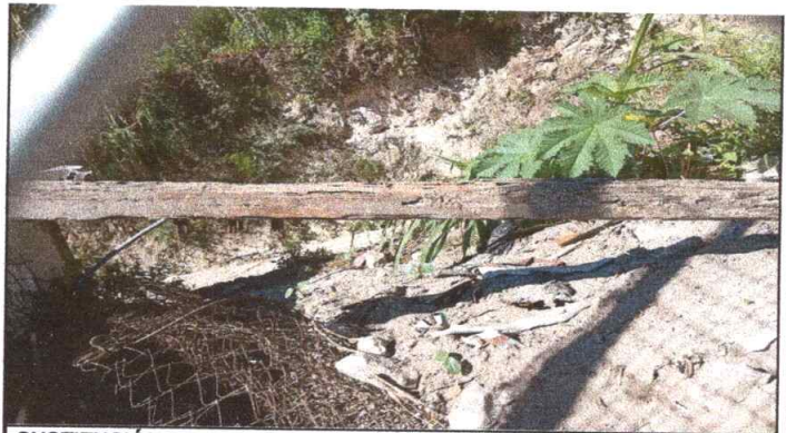
SUSTITUCIÓN DE ESTRUCTURA DE SOPORTE DE METAL
