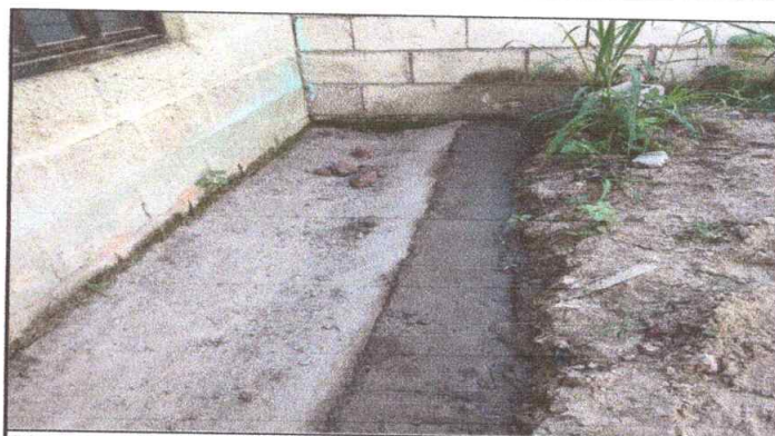
REPARACION DE CUNETAS
