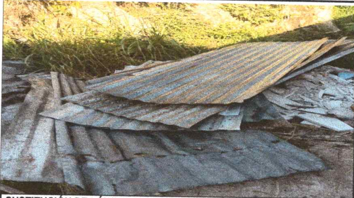
SUSTITUCIÓN DE LÁMINA ONDULADA POR LÁMINA TROQUELADA ALIZIN CALIBRE 26
