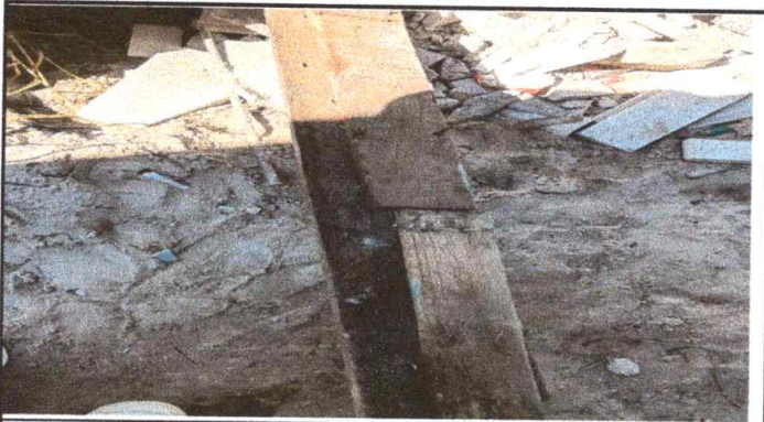
SUSTITUCIÓN DE ESTRUCTURA DE SOPORTE DE METAL
