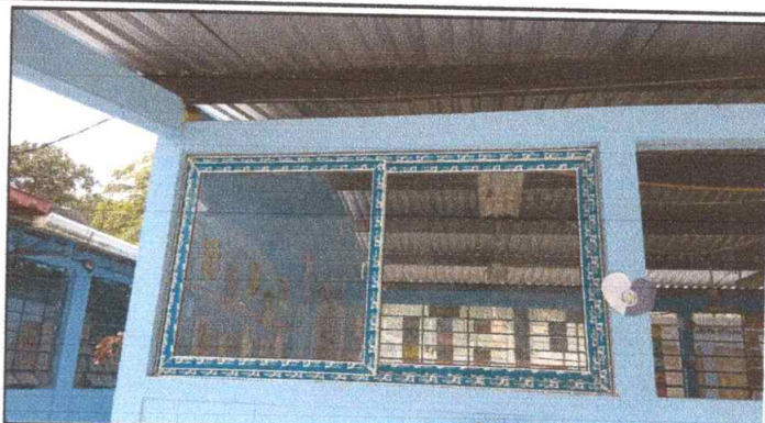
SUSTITUCION DE BALCONES DE METAL DE VENTANAS DE DEL AULA.
