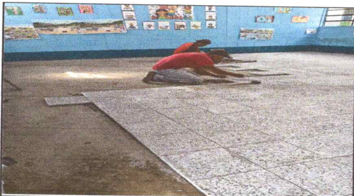
SUSTITUCION DE PISO DE CONCRETO POR GRANITO
