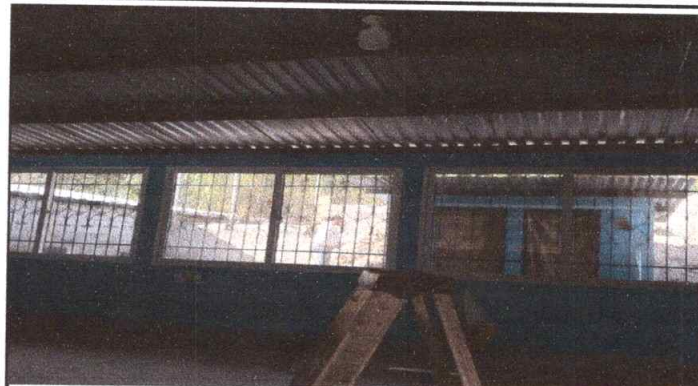
Foto 2: REPARACION DE SISTEMA ELECTRICO: SUSTITUCION DE LAMPARAS TIPO LED (REFLECTOR)
