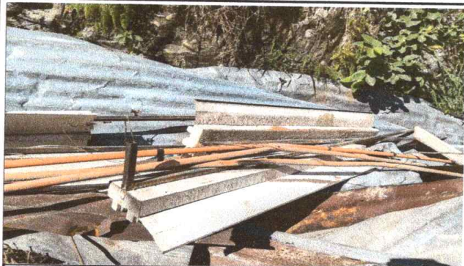
Foto 1: REPARACION DE SISTEMA ELECTRICO: REPARACION DE CABLEADO ELECTRICO
