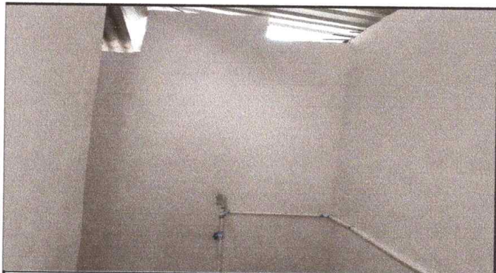
Foto 3: REPARACION DE REPELLO Y CERNIDO DE PAREDES (CUANDO APLIQUE): REPELLO EN PAREDES
