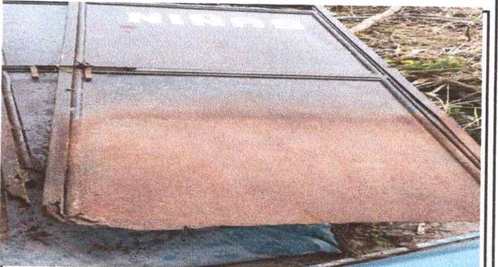
MANTENIMIENTO A ESTRUCTURA DE PUERTA (LIJADO, CAMBIO DE TUBO. CEPILLADO, SUJECIONES, APLICACIÓN DE PINTURA)
