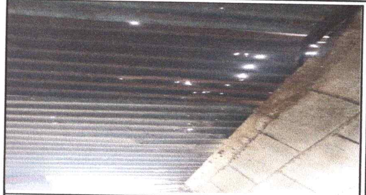
SUSTITUCIÓN DE ELEMENTOS DE FIJACIÓN
