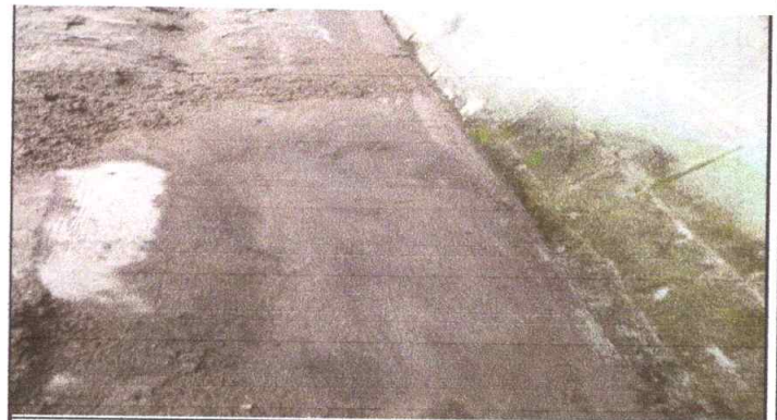
REPARACION DE CUNETA
