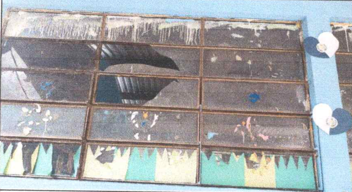
SUSTITUCION DE VENTANAS DE METAL POR UPVC MAS VIDRIO.
