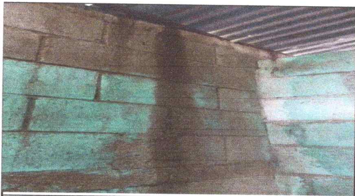
REPELLO EN PAREDES
