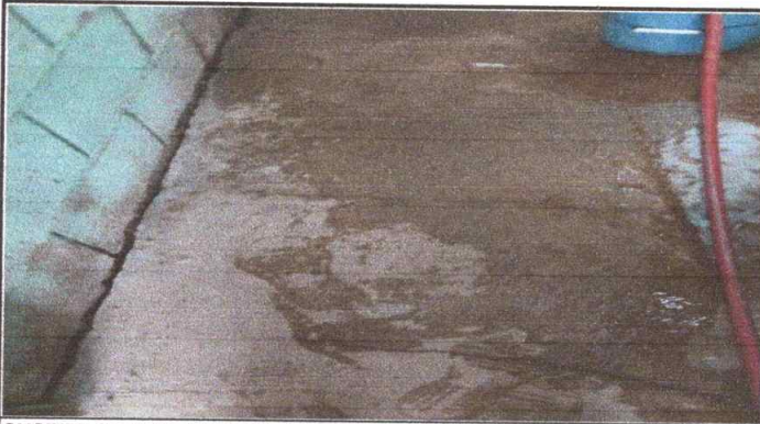
SUSTITUCION DE PISO DE CONCRETO POR GRANITO
