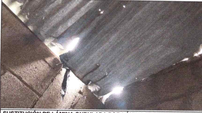
SUSTITUCIÓN DE LÁMINA ONDULADA POR LÁMINA TROQUELADA ALIZÍN CALIBRE 26
