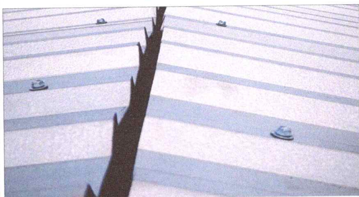
Foto 3: Sustrucción de elementos de fijación
