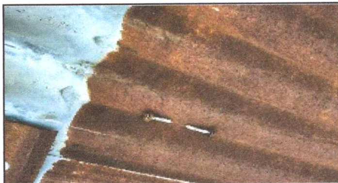
Foto 3: Sustitución de elementos de fijacion
