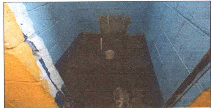
Foto 6: Sustitución de sanitarios
