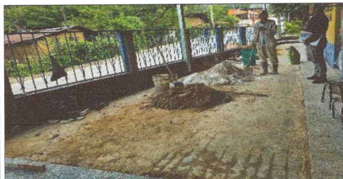
Foto 5: Sustitución de piso torta de cemento por piso de granito
