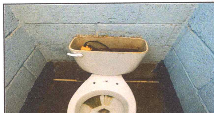
Foto 6: Sustrucción de sanitarios
