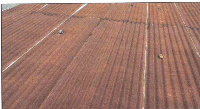
Foto 3: Sustrucción de elementos de fijación
