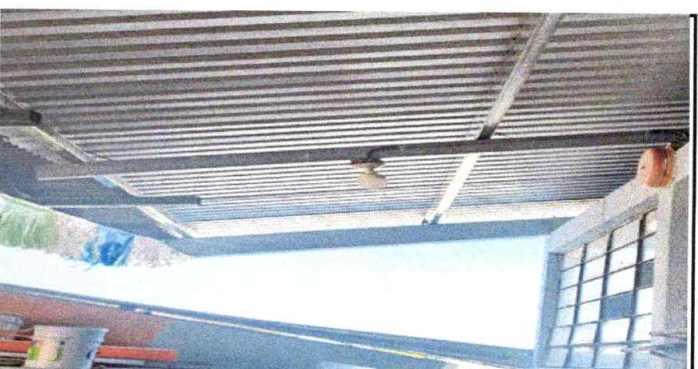
Foto 12: Sustitución de plafoneras
