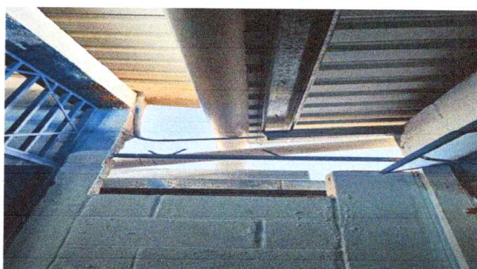
Foto 4: Reparación de bajada de agua pluvial, tubo PVC de 3 "
