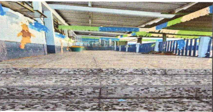
Foto 5: Sustitución de piso de granito
