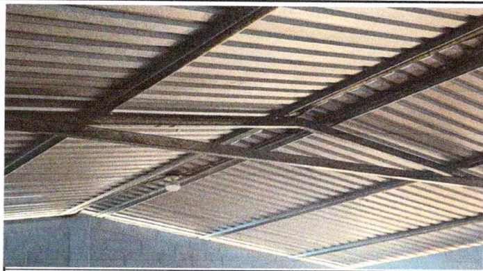
Foto1: Reparación de sistema eléctrico
