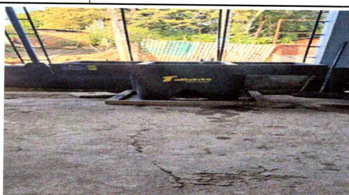
Foto 8: Sustitución de pila plastica de dos lavaderos
