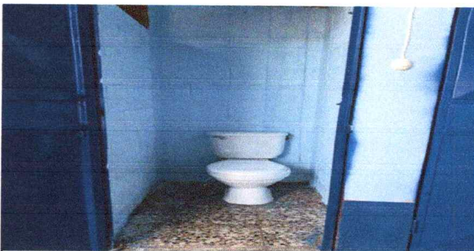
Foto 6: Sustitución de inodos
