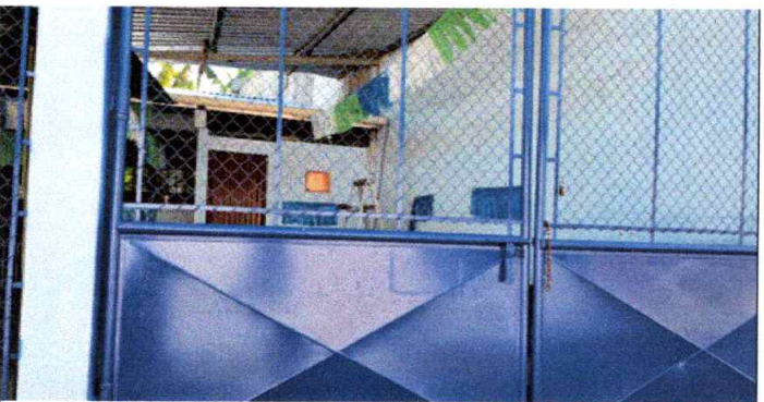
Foto 11: Mantenimiento a estructuras de portón y puertas
