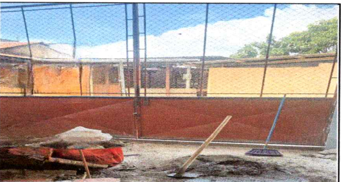
Foto 11: Mantenimiento a estructuras de portón y puertas
