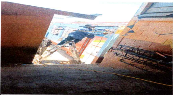
Foto 9: Sustitución de soporte o pescante de metal para canal
