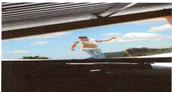
Foto 3: sustitucion de canales de PVC
