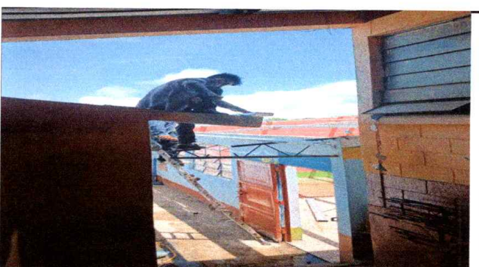
Foto 10: Sustitución de capote de lamina para lamina troquelada
