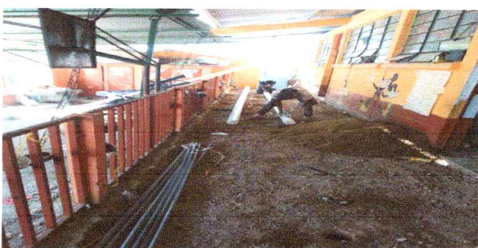
Foto 4: Reparación de bajada de agua pluvial, tubo PVC de 3 "
