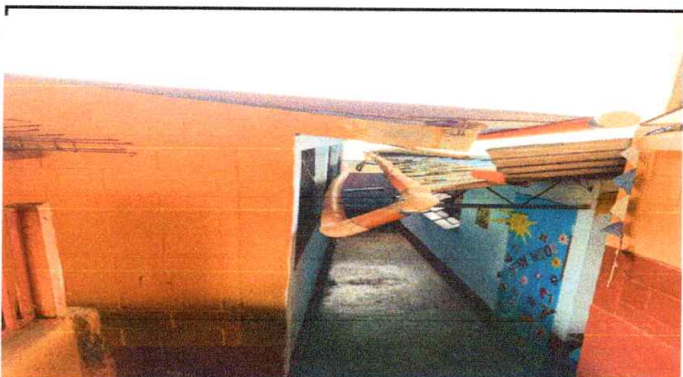
Foto 3: Sustitución de canal PVC
