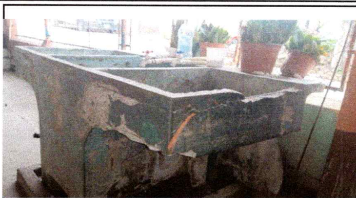
Foto 8: Sustrucción de pila plastica de dos lavaderos
