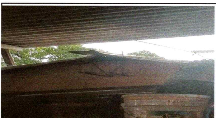
Foto 10: Sustrucción de capote de lamina para lamina troquelada
