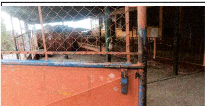
Foto 11: Mantenimiento a estructura de portón y puertas
