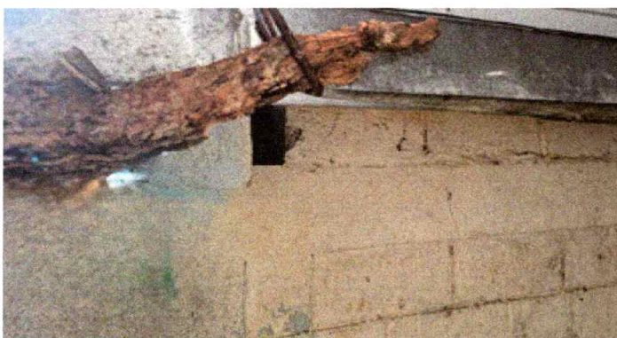
Foto 9: Sustrucción de soporte o pescante de metal para canal
