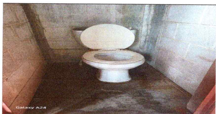
Foto 6: Sustitución de inodos
