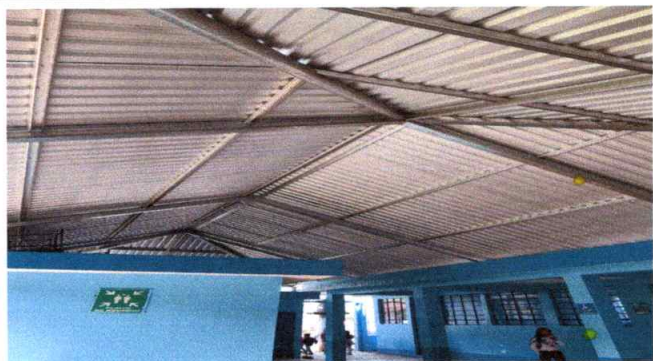
Foto1: Sustitución de lámina troquelada , aluzinc calibre 26 en patio.
