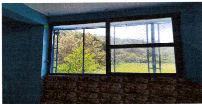
Foto 5: Sustitución de vidrios
