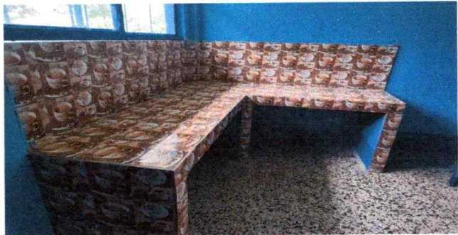
Foto 7: Instalación de azulejos en mueble de cocina.
