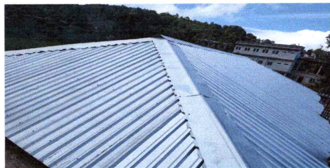
Foto 2: Sustitución de capote para lámina troquelada
