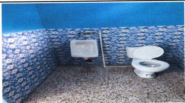
Foto 11: instalación de mingitorios
