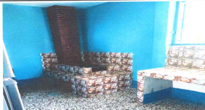
Foto 2: Pintura de muros exteriores e interiores
