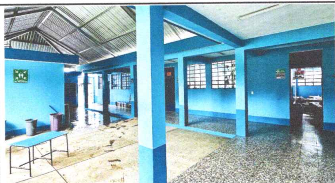
Foto 3: Pintura de muros exteriores e interiores
