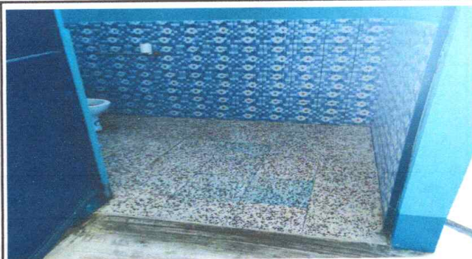
Foto 4: Sustitución de piso antideslizante por piso de granito en sanitarios
