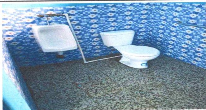
Foto 5: Sustitución de piso antideslizante por piso de granito en sanitarios
