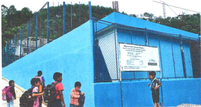
Foto 1: Pintura de muros exteriores e interiores
