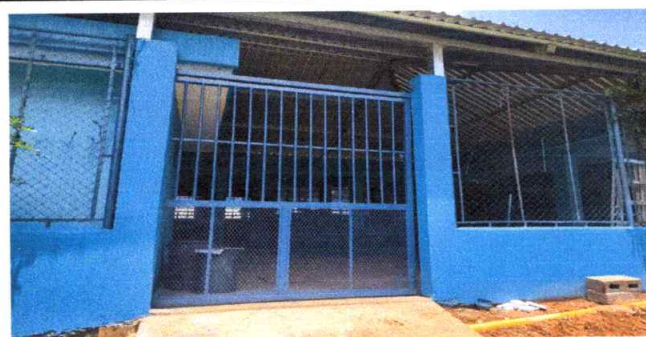
Foto 12: Sustitución de portón de metal de 2.50 mts. De alto 2.10 mts. De ancho
