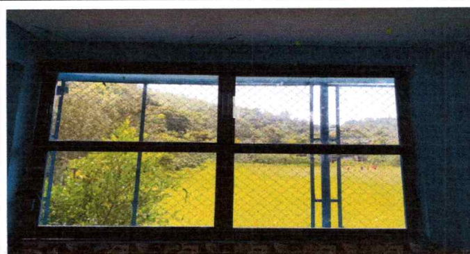
Foto 4: Sustitución de estructura de metal de ventana
