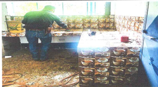
Foto 7: Instalación de azulejos en mueble de cocina
