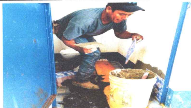
Foto 10: Instalación de azulejos sanitarios
