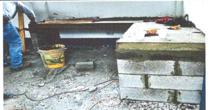
Foto 6: Mejoramiento de mueble de cocina
