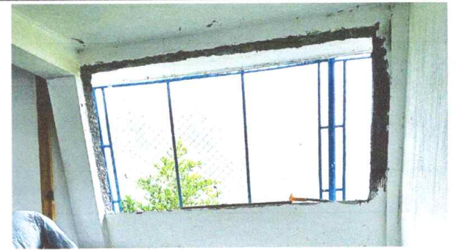
Foto 4: Sustrucción de estructura de metal de ventana
