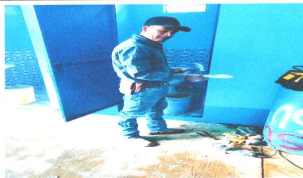
Foto 2: Pintura de muros exteriores e interiores
