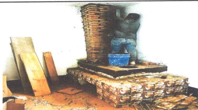
Foto 9: Instalación de azulejos en estufa rural
