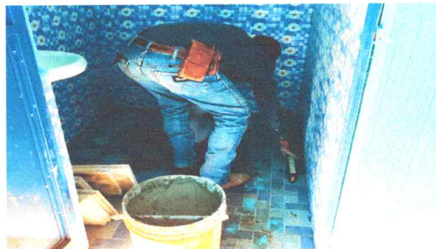
Foto 4: Sustitución de piso antideslizante por piso de granito en sanitarios
