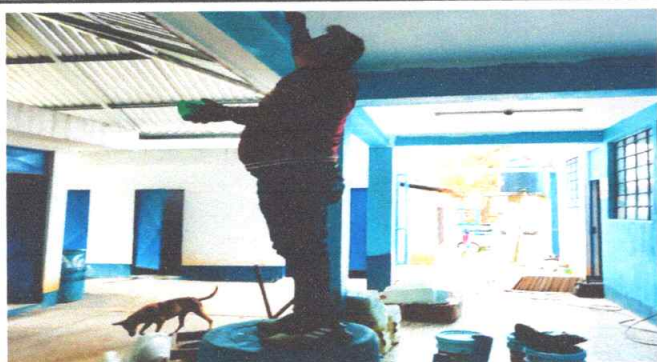
Foto 3: Pintura de muros exteriores e interiores
