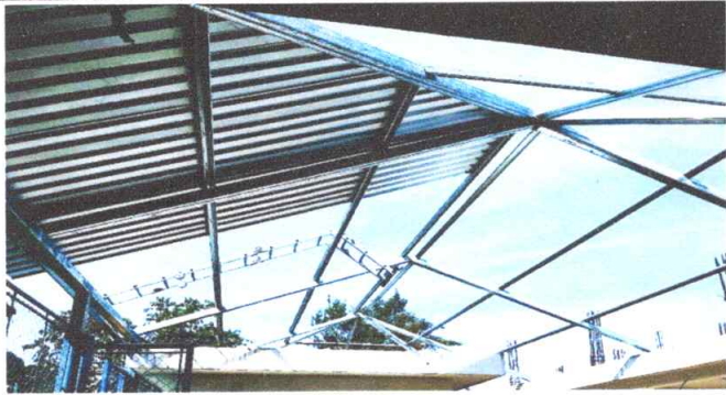
Foto 1: Sustrucción de lámina por lámina troquelada, aluzinc calibre 26 en patio
