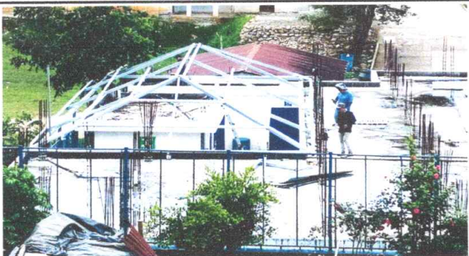
Foto 3: Sustrucción de estructura de soporte de metal por metal
