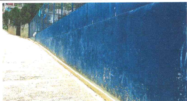
Foto 1: Pintura de muros exteriores e interiores
