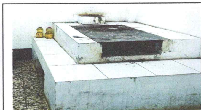
Foto 9: Instalación de azulejos en estufa rural
