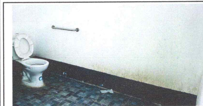
Foto 11: Instalación de migitorios
