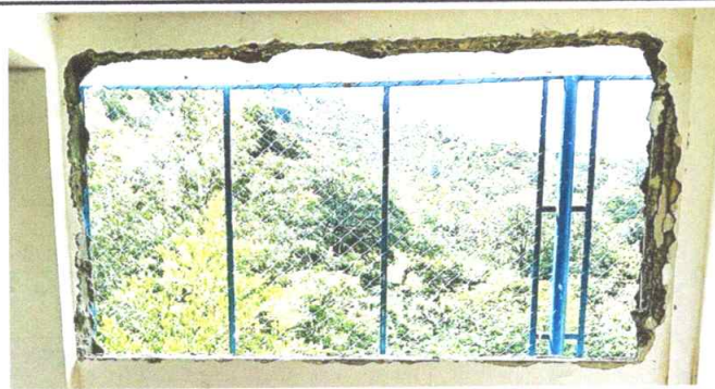
Foto 5: Sustrucción de vidrios
