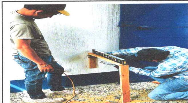
Foto 7: Instalación de azulejos en mueble de cocina
