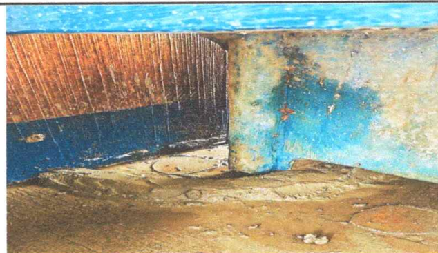
Foto 2: Pintura de muros exteriores e interiores
