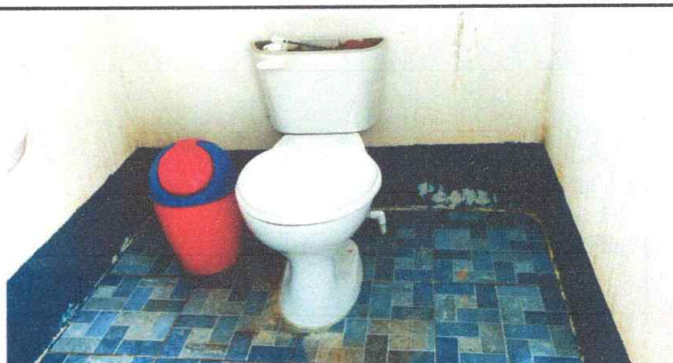
Foto 10: Instalación de azulejos sanitarios
