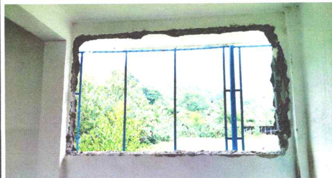
Foto 4: Sustrucción de estructura de metal de ventana
