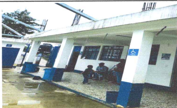
Foto 3: Pintura de muros exteriores e interiores
