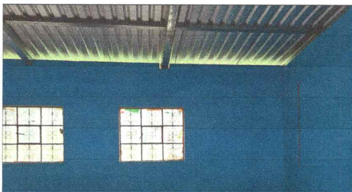
Foto 4: MEJORAMIENTO DE CERRAMIENTO DE PARED
