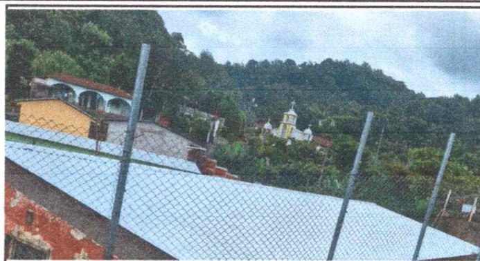
Foto 2: SUSTITUCION DE CAPOTE DE LAMINA, POR LAMINA TROQUELADA
