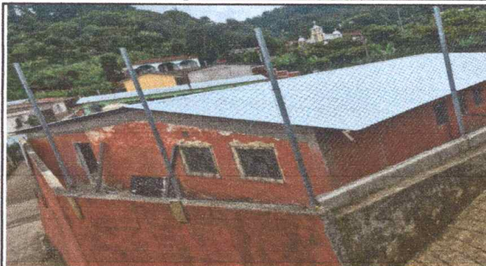
Foto1: SUSTITUCION DE LAMINA, POR LAMINA TROQUELADA
