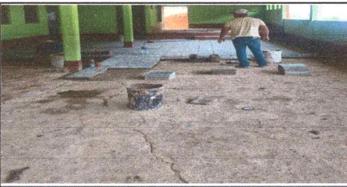
Foto 5: SUSTITUION DE PISO DE TORTA DE CONCRETO, POR PISO DE GRANITO
