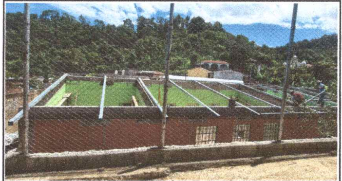
Foto 2: SUSTITUCION DE CAPOTE DE LAMINA, POR LAMINA TROQUELADA
