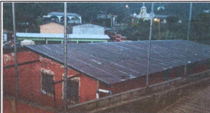
Foto1: SUSTITUCION DE LAMINA, POR LAMINA TROUELADA
