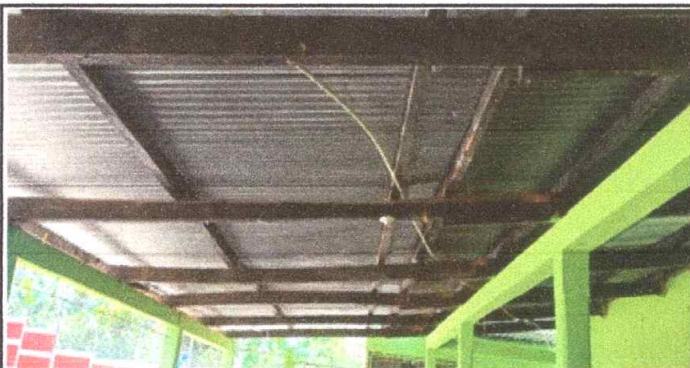
Foto 3: SUSTITUCION DE ESTRUCTURA DE SOPORTE DE MADERA, POR METAL
