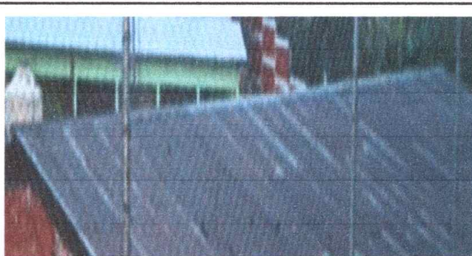
Foto 2: SUSTITUCION DE CAPOTE DE LAMINA, POR LAMINA TROUELADA
