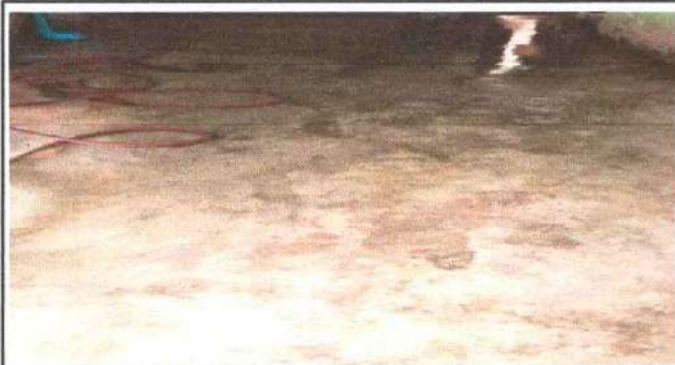
Foto 7: Sustrucción de piso de concreto por piso de granito en baños.
