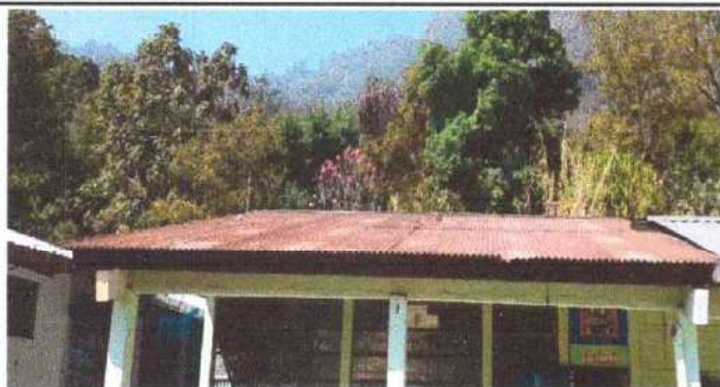
Foto1: Sustitución de lámina, por lámina troquelada.
