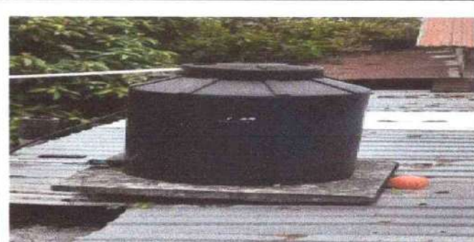
Foto 10: Sustrucción de depósito de agua.
