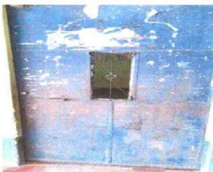
Foto 3: Cambio de chapas.
