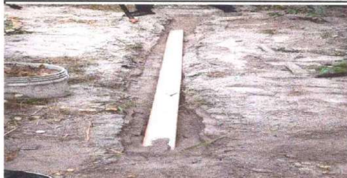
Foto 14: Sustitución de tubería PVC de 3 pulgadas en línea principal de aguas negras.
