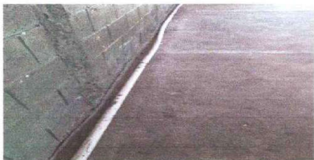
Foto 15: Sustitución de tubería línea principal red de agua potable en baños.
