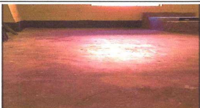
Foto 5: Sustitución de piso de torta de concreto por piso de granito en cocina.
