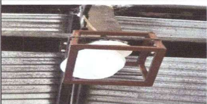
Foto 9: Sustrucción de focos ahorradores.
