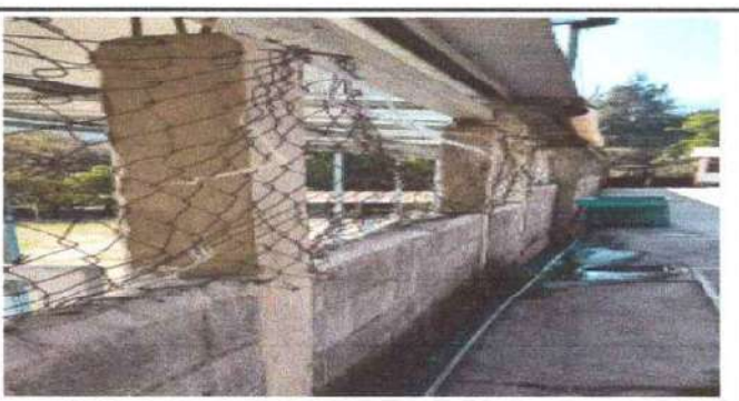
Foto 12: Reparación de muro perimetral con malla galvanizada y planas de metal.
