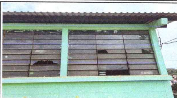
Foto 8: Sustitución de vidrios
