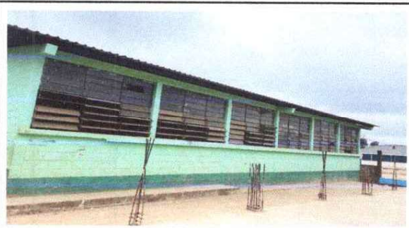
Foto 7: Mejoramiento de bajada de agua pluvial
