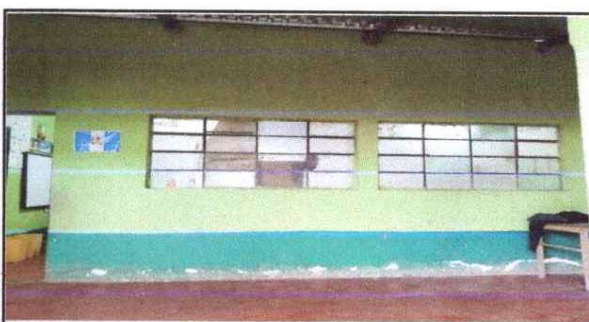
Foto 12: Pintura en muros exteriores e interiores
