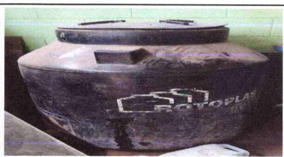
Foto 6: Sustitución de depósito de agua
