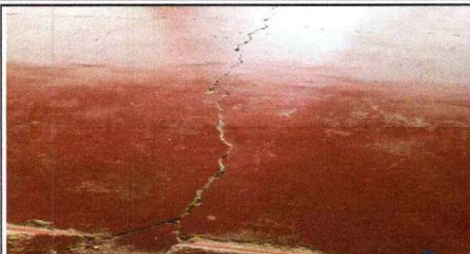
Foto1: Sustrucción de piso de concreto por piso de granito
