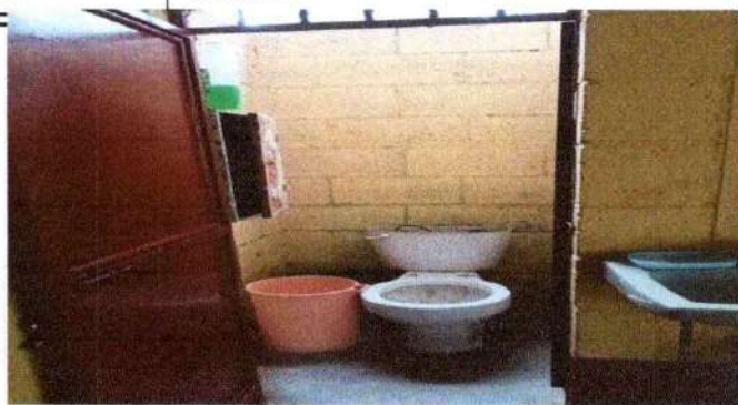
Foto 2: Mejoramiento de pared de baños con azulejo
