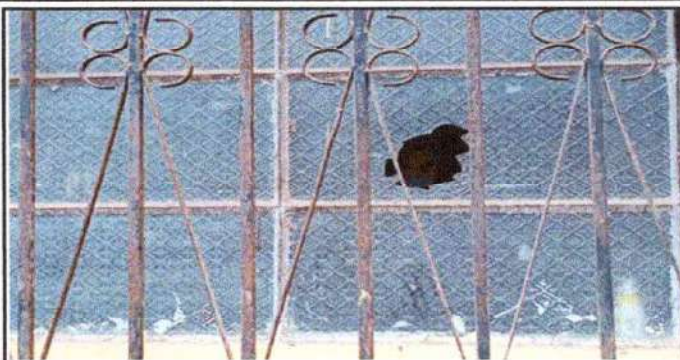
Foto 2: Sustrucción de ventanas existentes por ventana corrediza PVC blanco
