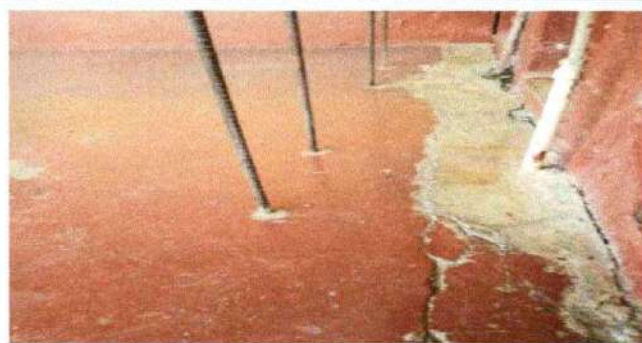
Foto 4: Sustrucción de piso de concreto por piso de granito
