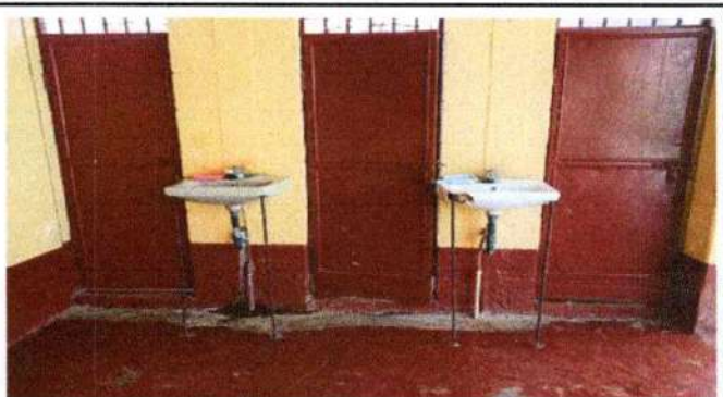
Foto 4: Instalación de azulejo en lavamanos
