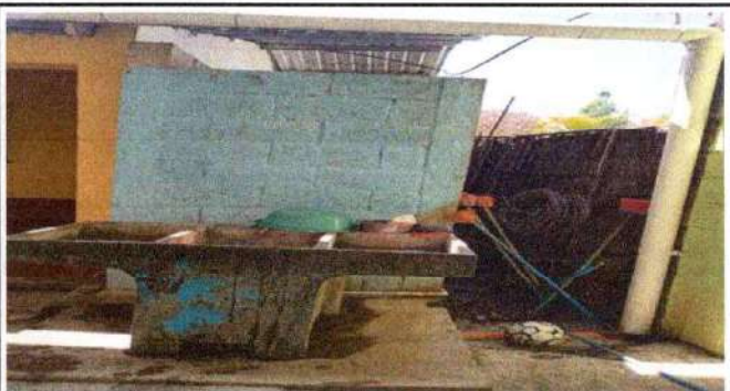
Foto 4: mejoramiento a piso de cemento para pila de dos lavaderos
