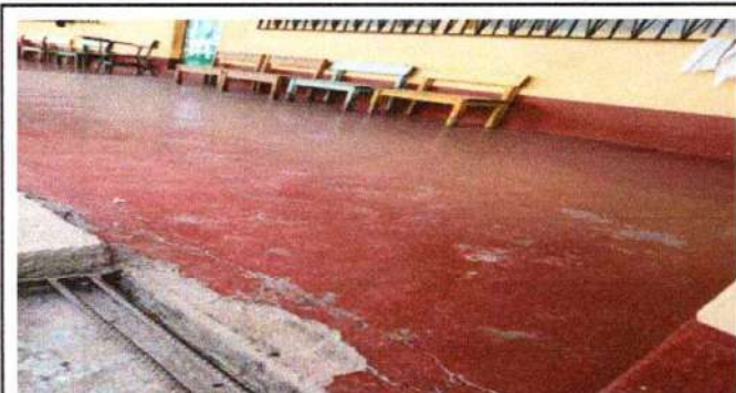
Foto 3: Sustrucción de piso de concreto por piso de granito
