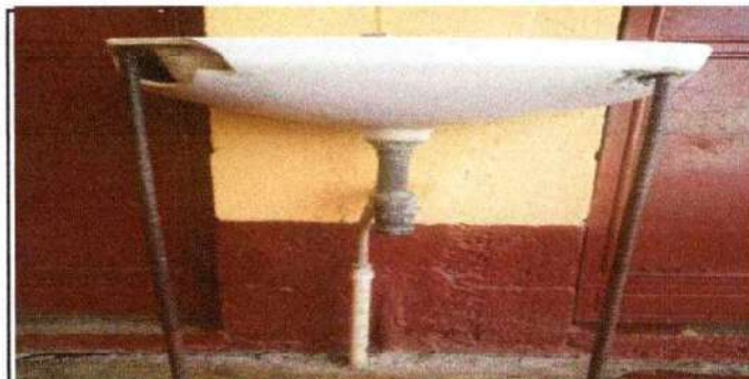
Foto 6: sustitución de lavamanos
