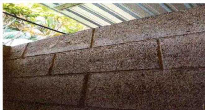
Foto 2: Repello en pared de baños
