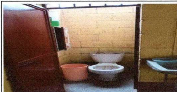
Foto 4: Sustrucción de inodoros
