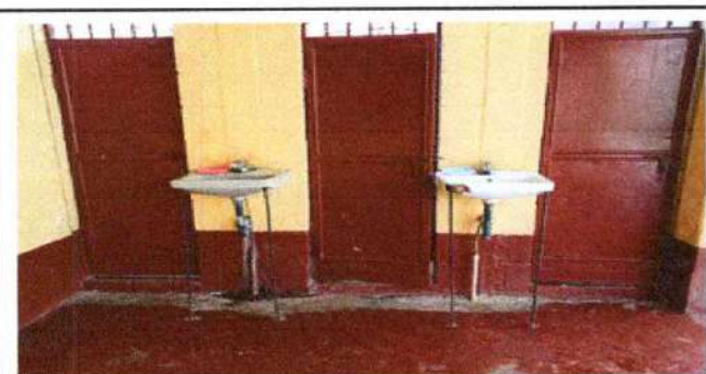
Foto 5: Sustrucción de lavamanos
