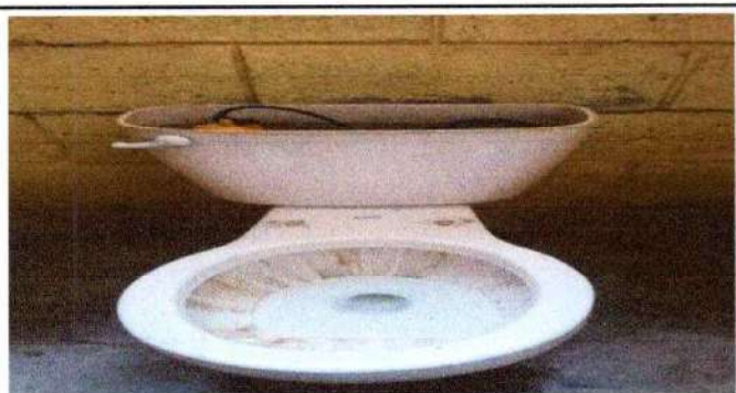
Foto 3: Sustrucción de inodoros
