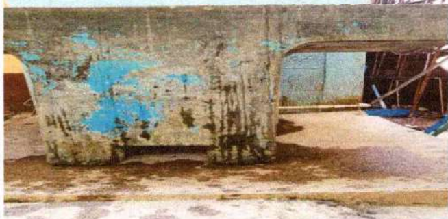
Foto1: Reparación de plancha de concreto en en pila
