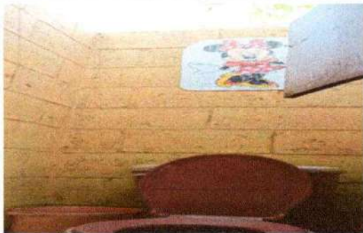
Foto1: Mejoramiento de pared en baños con azulejo
