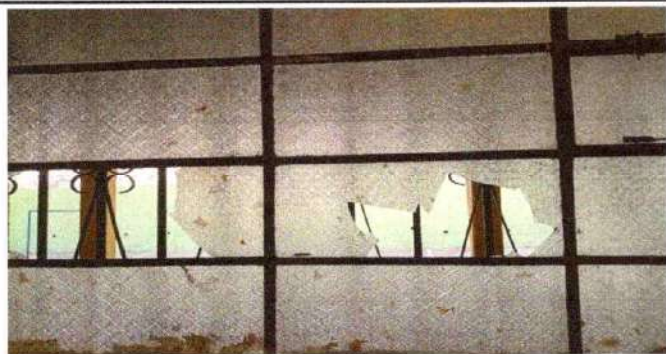
Foto1: Sustrucción de ventanas existentes por ventana corrediza PVC blanco
