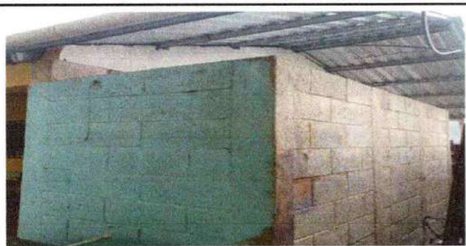
Foto 5: Mejoramiento de pared de baños
