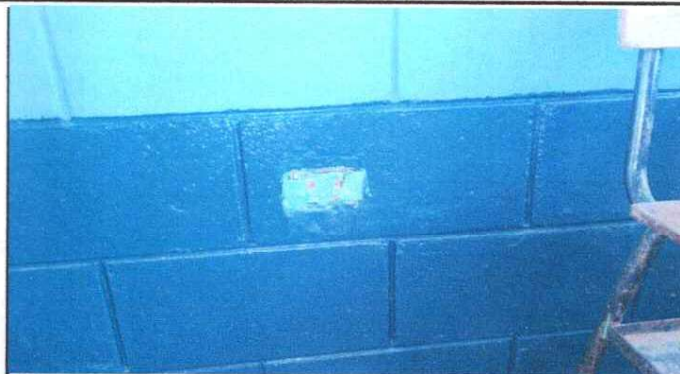
Foto 8: Sustrucción de tomacorrientes dobles
