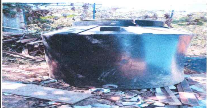
Foto 11: Sustrucción de deposito de agua 1100 lt
