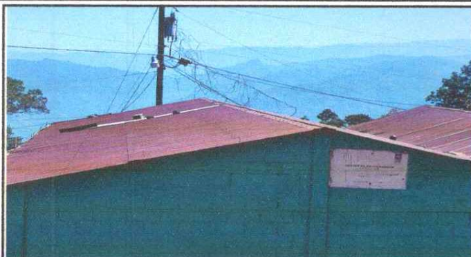
Foto 1: Sustrucción de lámina, por lámina troquelada aluzinic calibre 26
