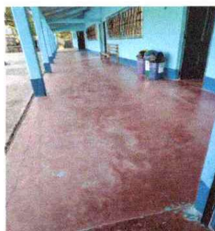
Foto 5: Sustitución de piso de torta de cemento por piso de granito
