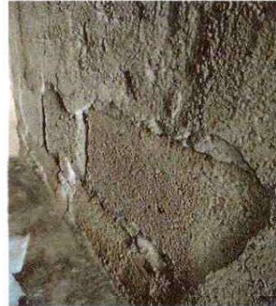
Foto 4: Sustitución de repello en muros interiores y exteriores de sanitarios
