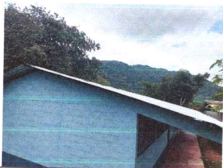
Foto1: Sustrución de capote de lámina para lámina troquelada
