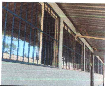
Foto 3: Sustrución de ventana de metal por ventana de UPVC color blanco mas vidrio transparente
