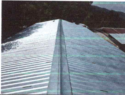
Foto1: Sustitución de capote de lámina para lámina troquelada
