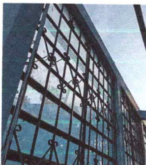
Foto 3: Sustrucción de ventana de metal por ventana de UPVC color blanco mas vidrio transparente
