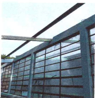
Foto 1: Sustrucción de lámina troquelada aluzinc calibre 26
