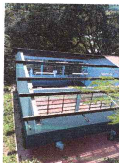
Foto 2: Sustrucción de lámina troquelada Aluzinc calibre 26
