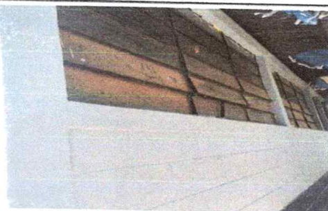
Foto 4: Sustitución de ventanas de metal por ventana de UPVC color blanco mas vidrio transparente
