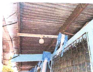
Foto 6: Sustitución de estructura de soporte de metal, por metal
