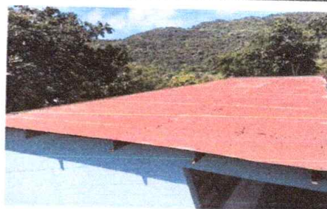
Foto 2: Sustitución de lámina troquelada Aluzinc calibre 26
