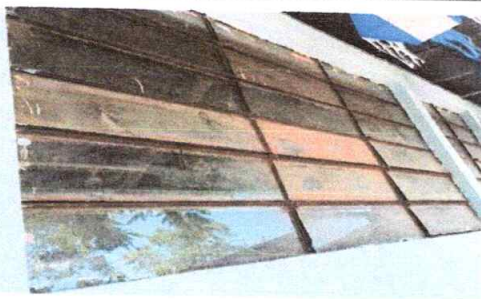
Foto 3: Sustitución de ventanas de metal por ventana de UPVC color blanco mas vidrio transparente
