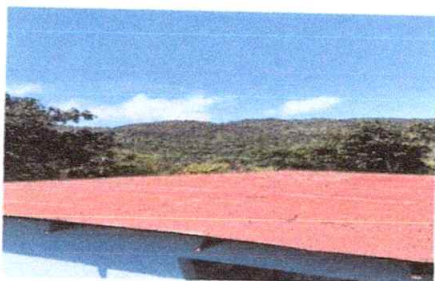
Foto 1: Sustitución de lámina troquelada Aluzinc calibre 26
