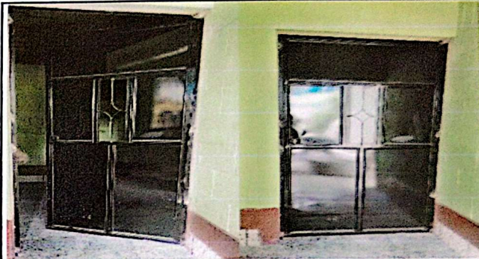
Foto 2: Sustitución de puerta de madera por metal
