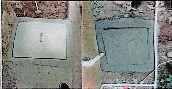
Foto 8: Sustitución de caja de registro
