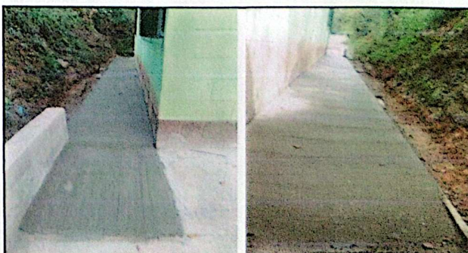
Foto 6: Reparación de cuneta de concreto
