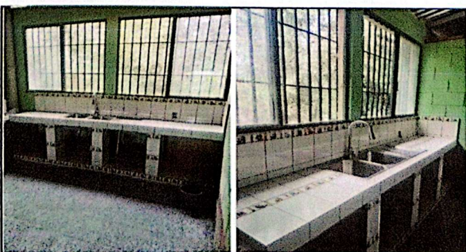
Foto 11: Mejoramiento de lavatrastos
