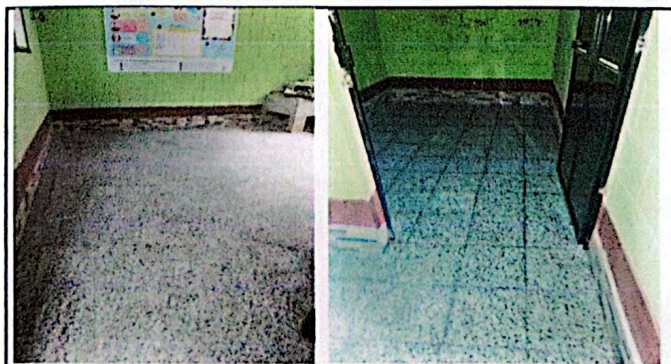
Foto 5: Sustitución de piso de torta de cemento por piso de granito
