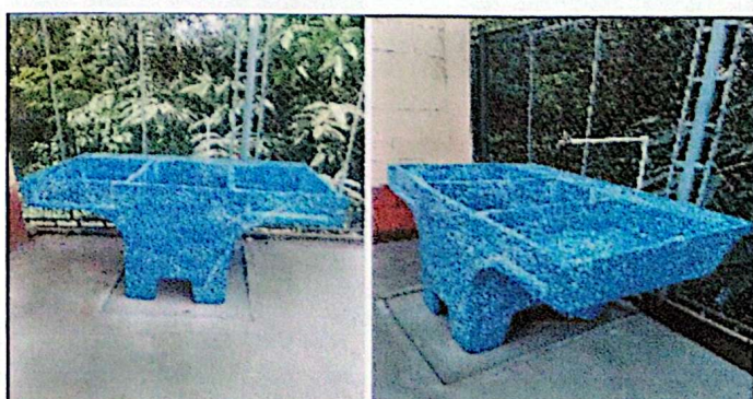
Foto 12: Sustitución de pila de dos lavaderos
