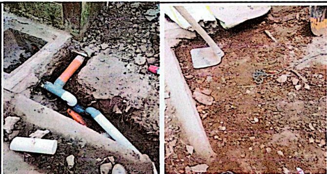
Foto 7: Sustitución de tubería PVC línea principal de aguas negras
