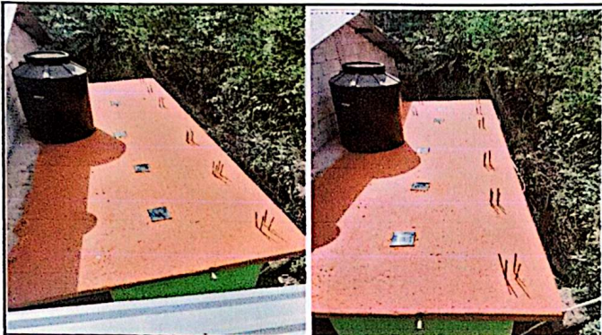
Foto1: Impearmibilización de losa
