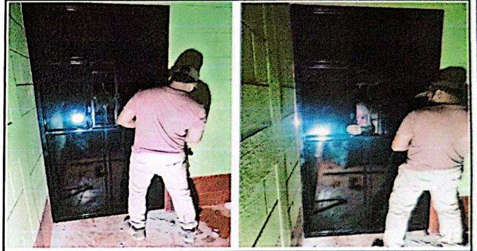
Foto 2: Sustitución de puerta de madera por metal
