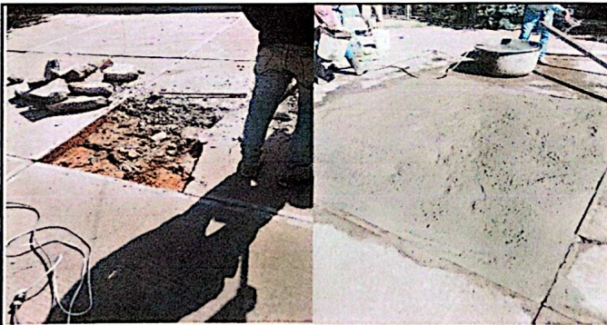
Foto 9: Reparación de planchas de concreto de patio
