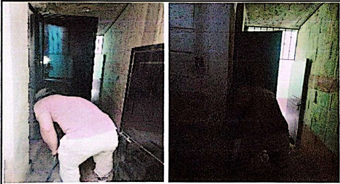
Foto 3: Sustitución de puertas en servicio sanitarios
