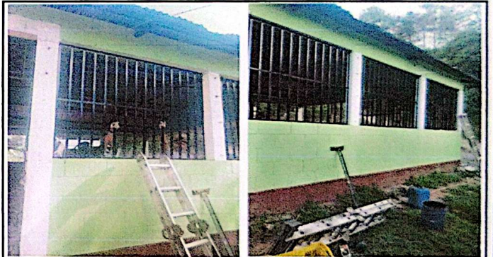
Foto 4: Sustitución de balcones de metal
