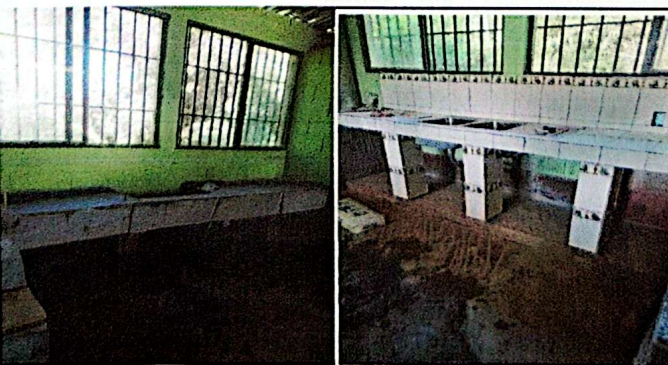
Foto 11: Mejoramiento de lavatrastos
