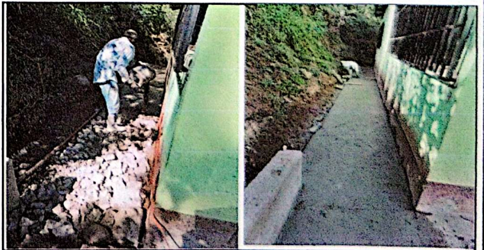
Foto 6: Reparación de cuneta de concreto
